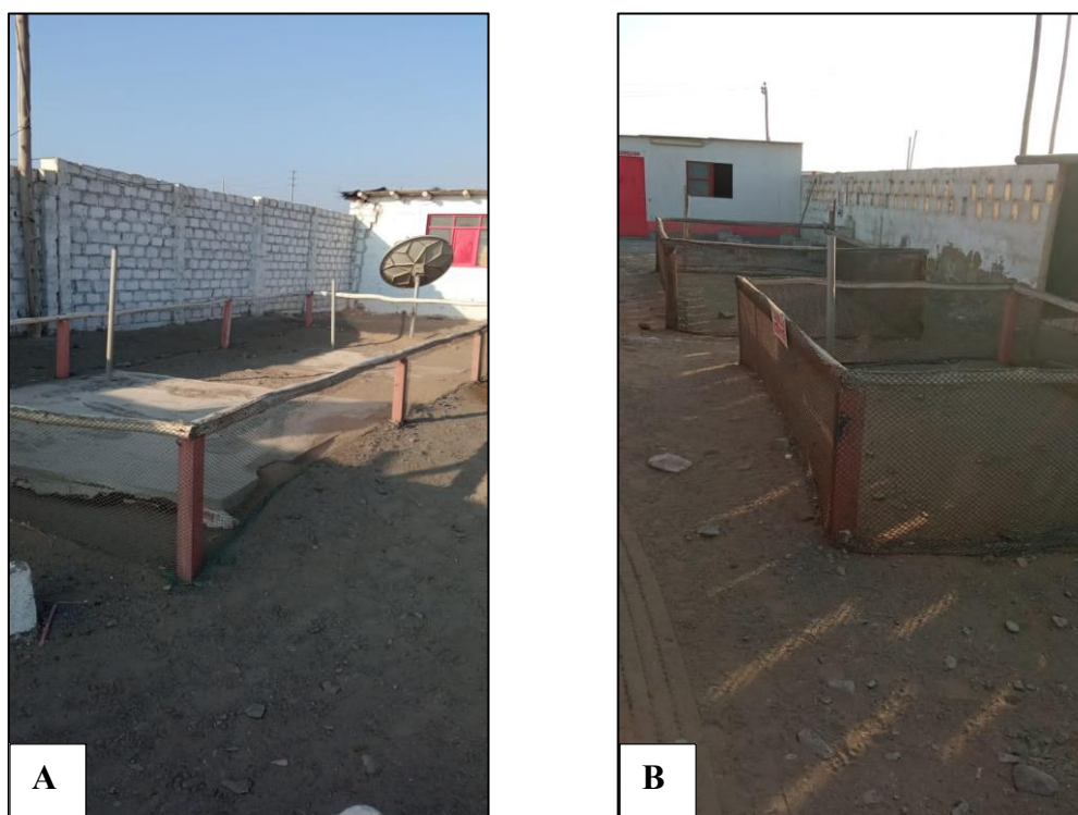
Figura 12. Pozos de percolación para vestuarios y SSHH A. Pozo de percolación del Vestuario de visitas a la UU. PP Atahuampa A. B. Pozo de percolación del vestuario de graneleros en Atahuampa A y B
