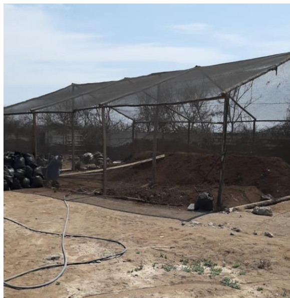
Figura 11. Primera Infraestructura de almacenamiento de pre compost.
