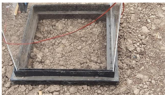
Instalación de la base de la cámara transparente (05/12/22)
