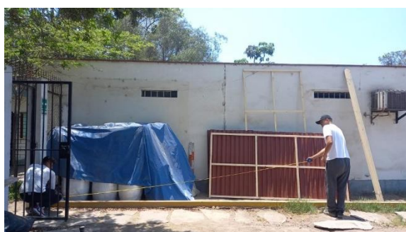
Construcción de techo protector para las cámaras
