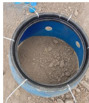
Instalación de la base de la cámara opaca (05/12/22)
