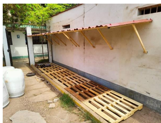
Techo protector de cámaras
