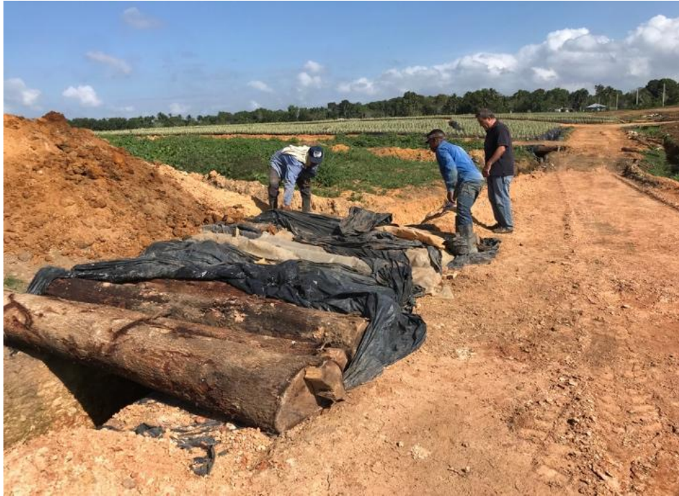
Figura 44. Elaboración de puentes
