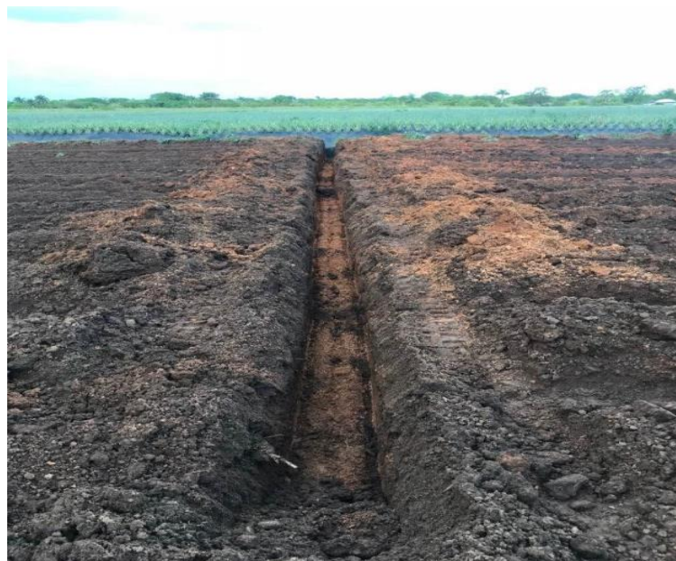
Figura 23. Drenes dentro de la plantación
