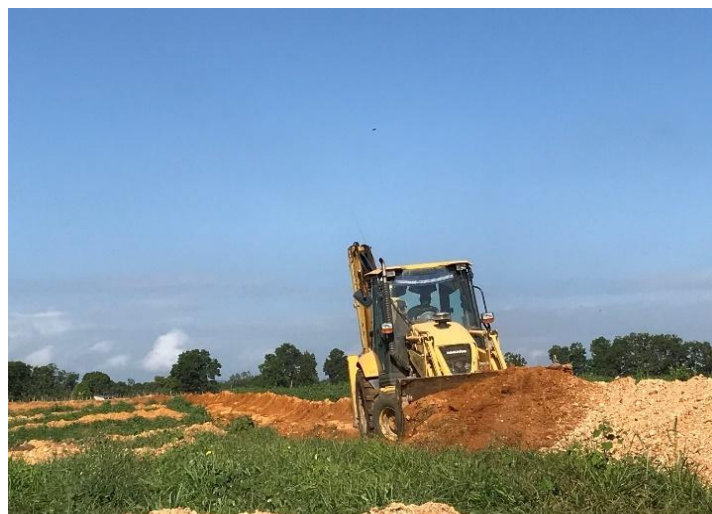
Figura 43. Maquinaria haciendo drenes
