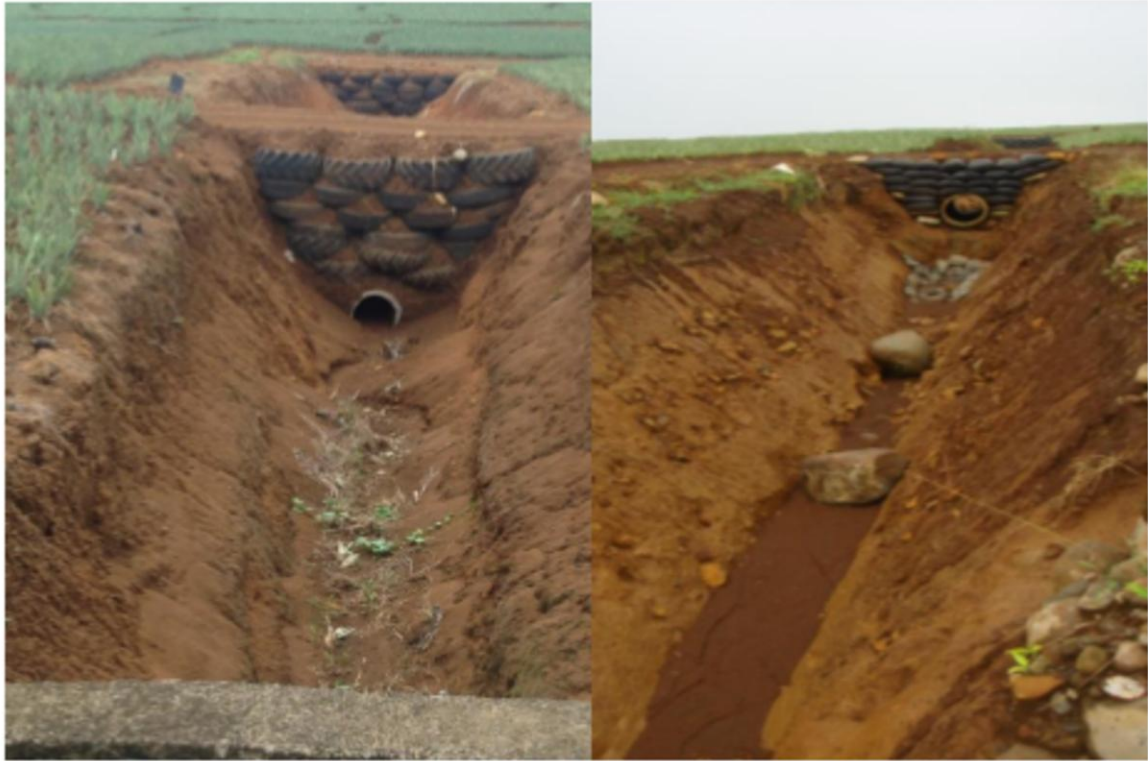
Figura 29. Ejemplo de canales primarios, pasos de maquinarias
