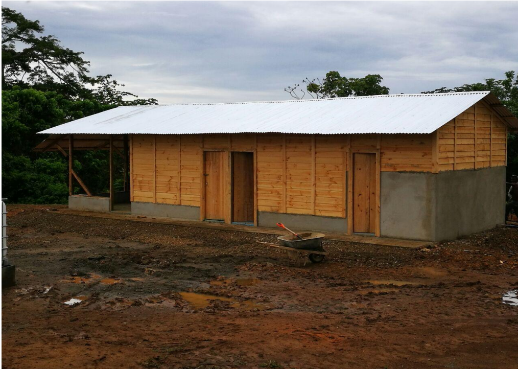
Figura 77. Viviendas para los trabajadores
