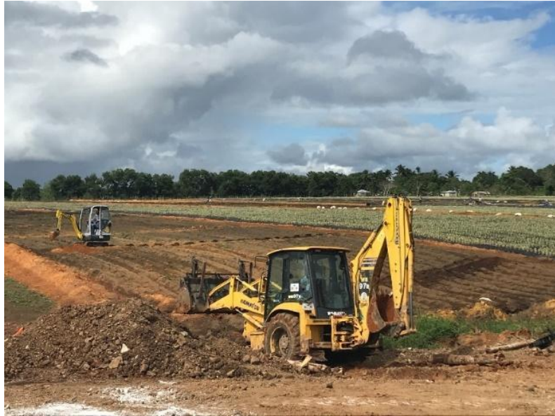
Figura 24. Maquinaria en plena construcción de drenes
