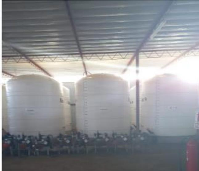
**Figura 6: Tanques de solución madre de 10000 litros.**
