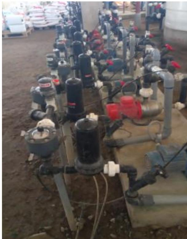
**Figura 7: Bombas de inyección, filtro y fertímetro.**
