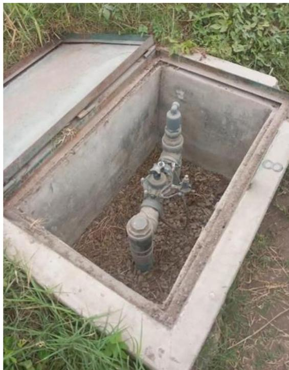
**Figura 2: Control secundario de una unidad de riego V-8**
