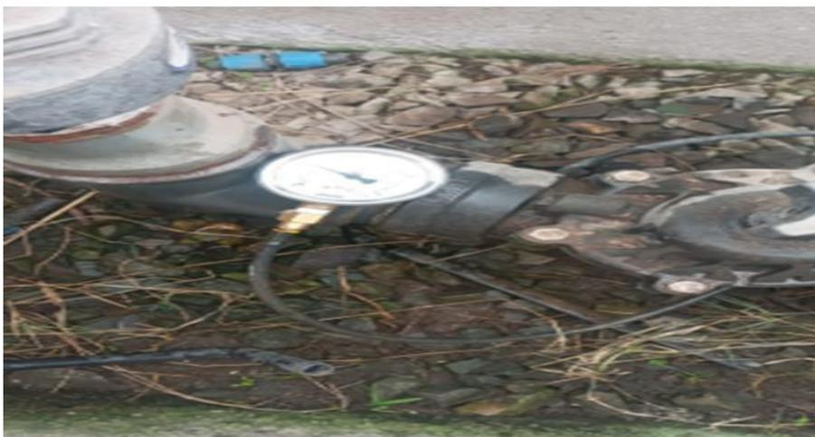
**Figura 16: Calibración de válvula (manómetro instalado en la válvula de control de la unidad de riego-2022)**
