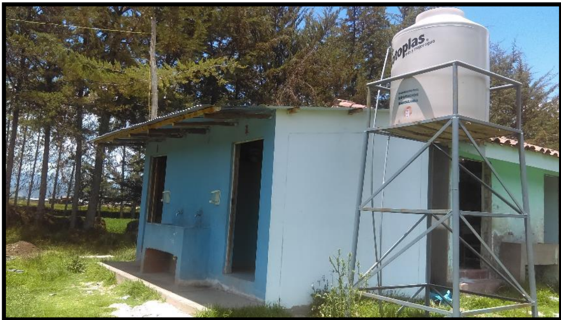
Figura 34: Baño nuevo con su respectivo tanque de almacenamiento
