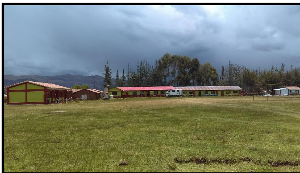
Figura 26: Vista general de las instalaciones de la Institución Educativa Haparquilla
