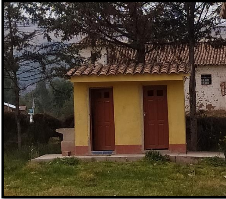
Figura 33: Vista del baño antiguo y su respectivo lavadero
