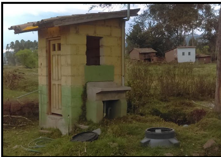
Figura 25: Instalación de un baño con arrastre hidráulico en la población de Haparquilla
