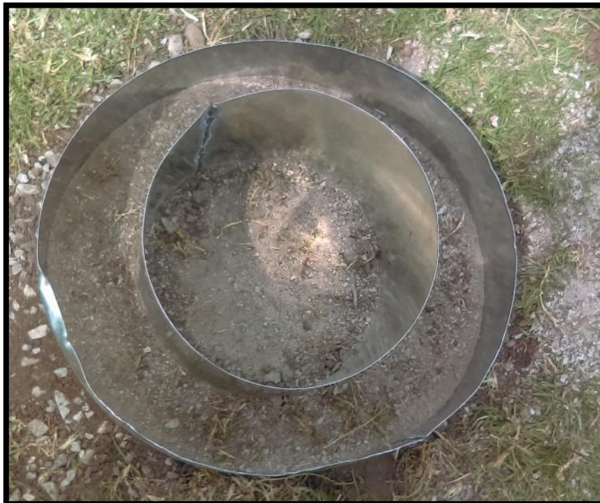
Figura 28: Instalación del doble anillo para la prueba de infiltración
