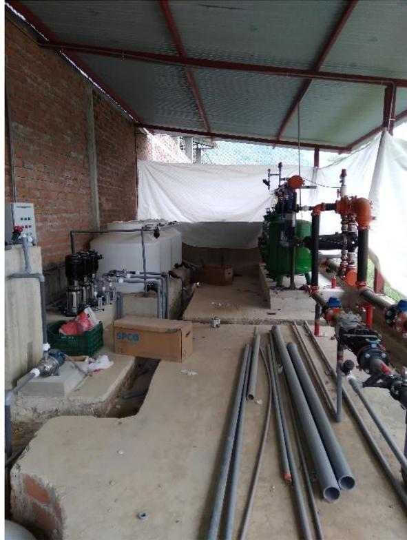
**Figura 9: Sistema de filtrado, fertilización y monitoreo**
