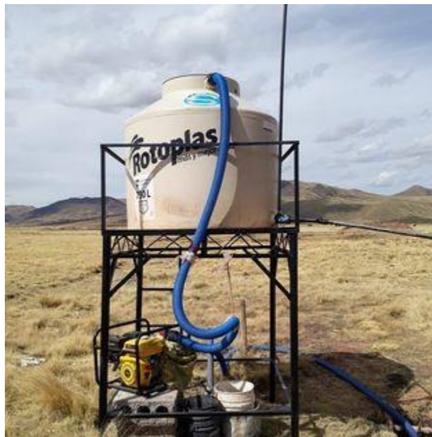
Figura 15: Implementación de tanque elevado y motobomba para suministro de agua de bebida
