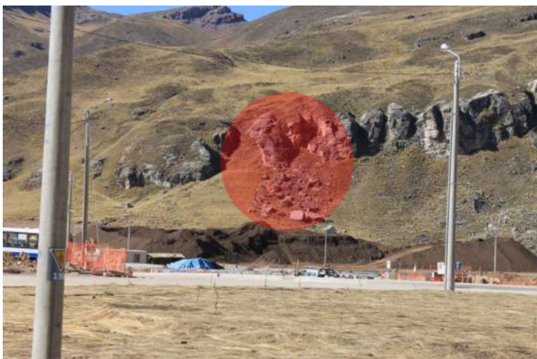
Figura 7:: Deslizamiento en la nueva ciudad de Morococha
