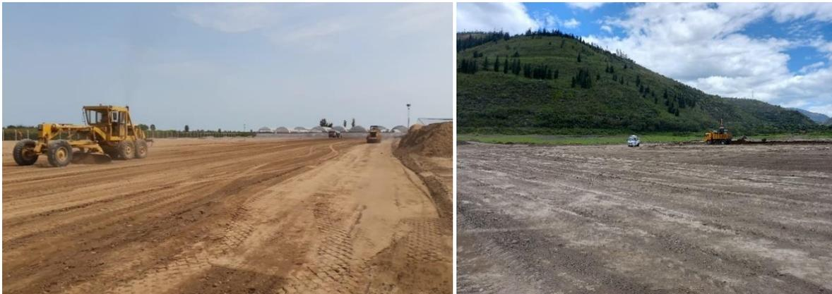
**Figura 12: Terrenos con micro-nivelación y mal drenaje por ser muy finos y pesados.**
