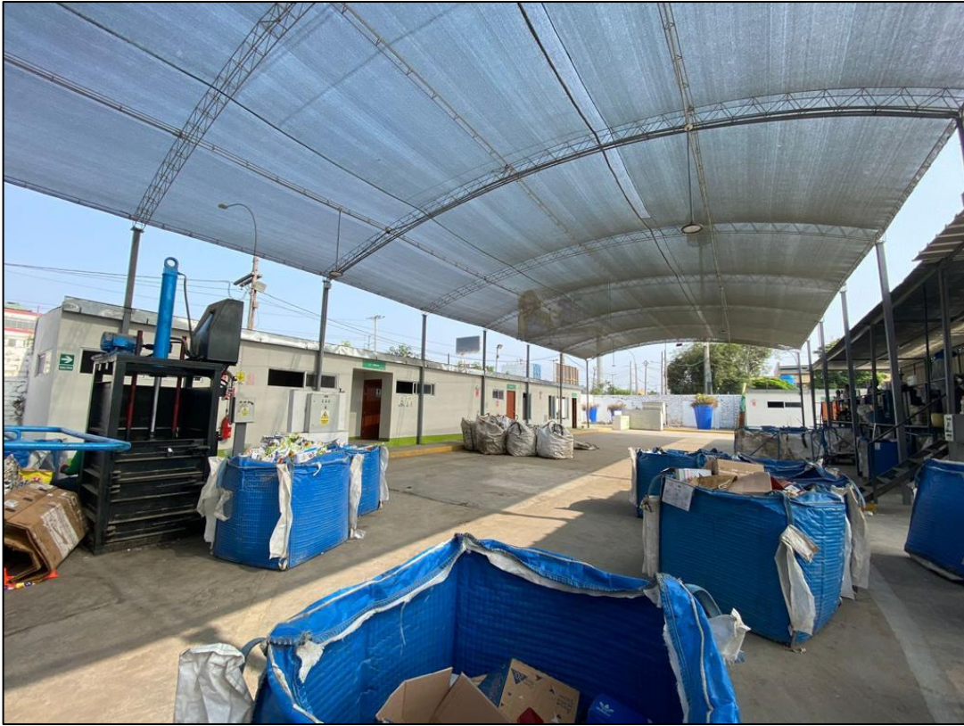
Fotografía 2. Planta de reciclaje de la municipalidad de La Molina desde PR-1. Elaboración propia.
