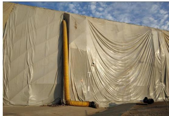
**Figura 7: Coberturado y sistema de extracción de polvos en la estructura donde se realizan trabajos de preparación de superficie mediante la técnica del chorro abrasivo seco**
