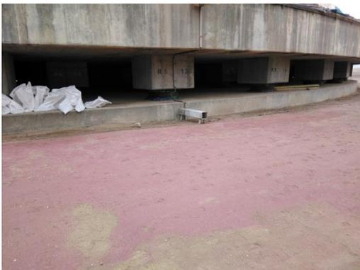
**Figura 6: Superficie de suelo desnudo cubierta con una capa de residuos de abrasivos usados en preparación de superficie mediante la técnica del chorro abrasivo húmedo**
