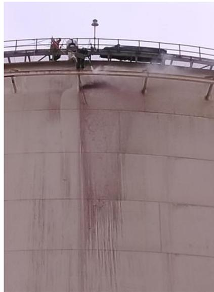
**Figura 2: Preparación de superficies mediante la técnica de chorro abrasivo húmedo o hidroarenado**
