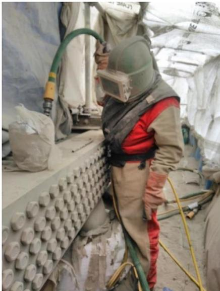
**Figura 1: Preparación de superficies mediante la técnica de chorro abrasivo seco o arenado**
