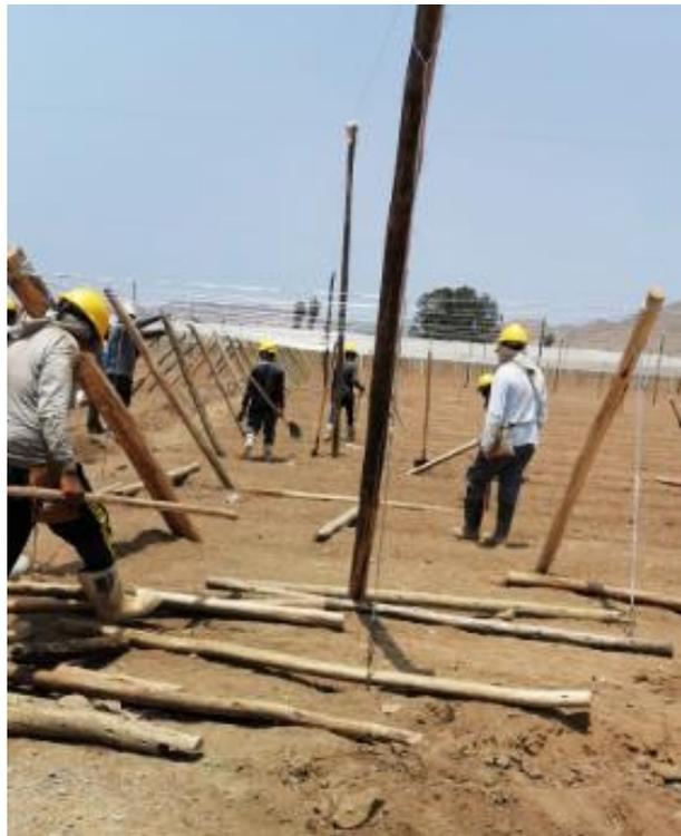
**Figura 9:** Instalación de palos de pinos para la estructura de la casa malla
