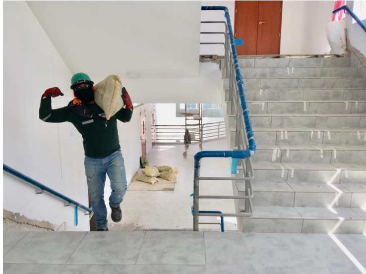
Figura 31. Acarreo de sustrato por escaleras
