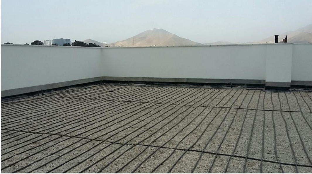
Figura 22. Tendido de mangueras de riego por goteo
