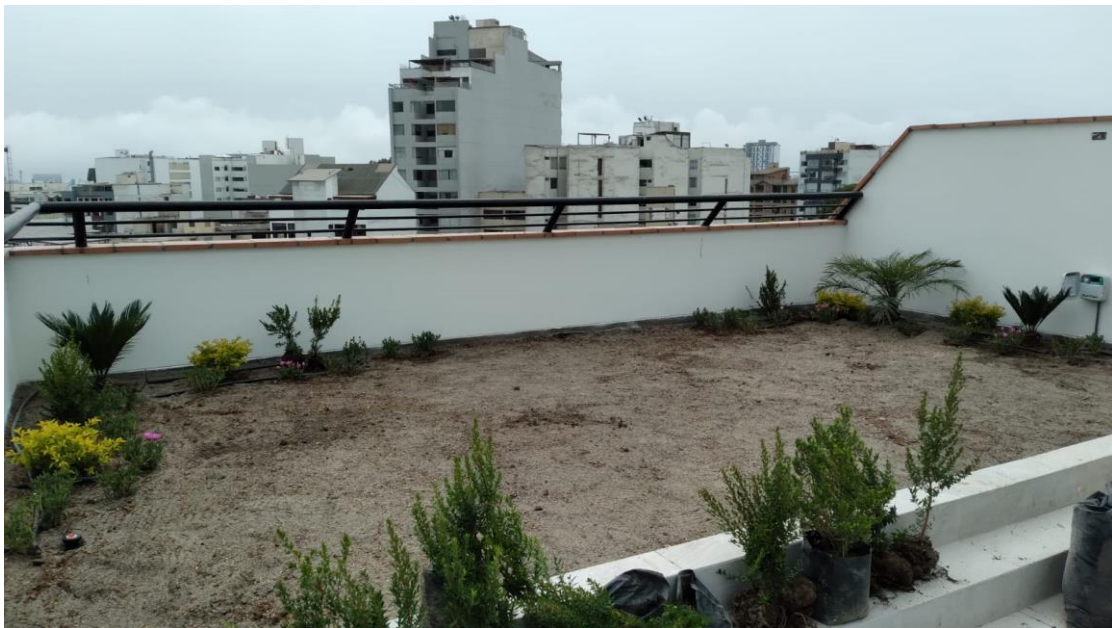
Figura 15. Sustrato con base en suelo y grava
