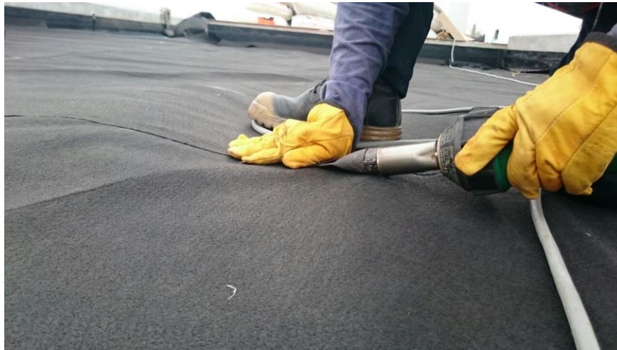
Figura 12. Instalación de capa filtrante
