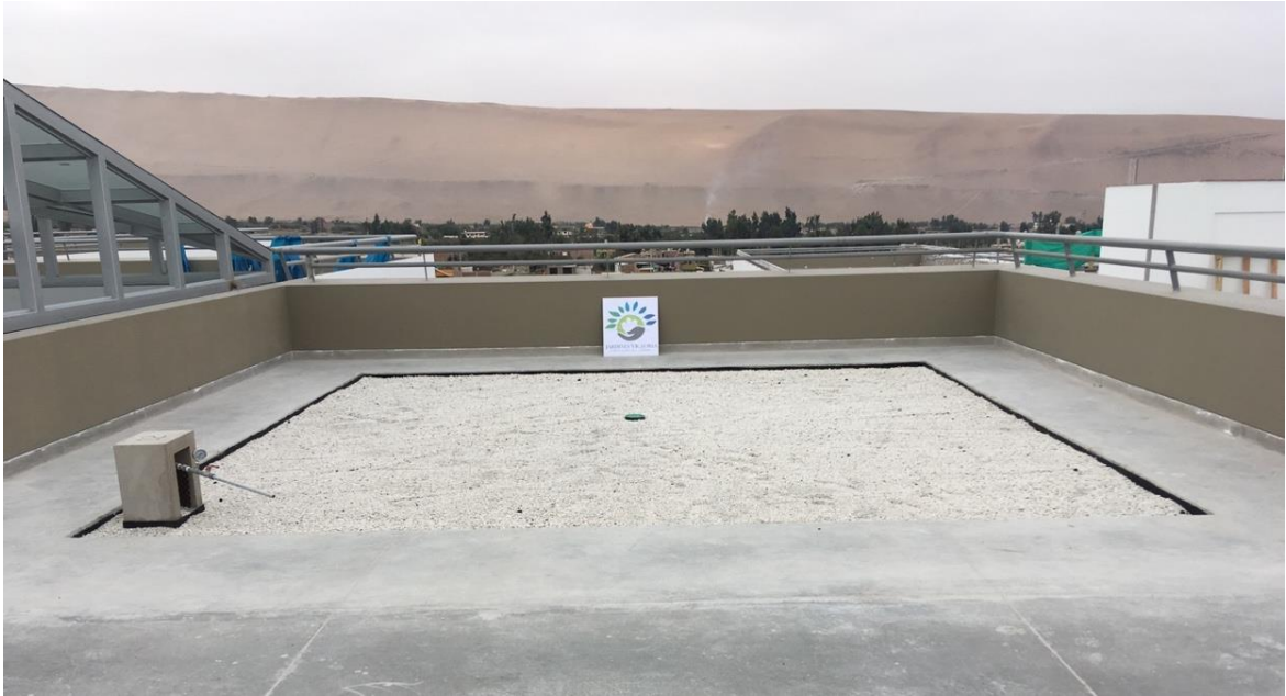
Figura 14. Sustrato ligero para techo verde instalado
