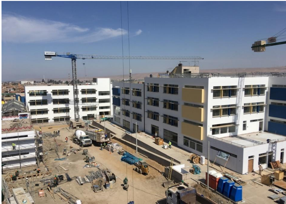
Figura 28. Proyecto en construcción
