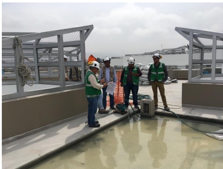
Figura 10. Aprobación de prueba de estanqueidad
