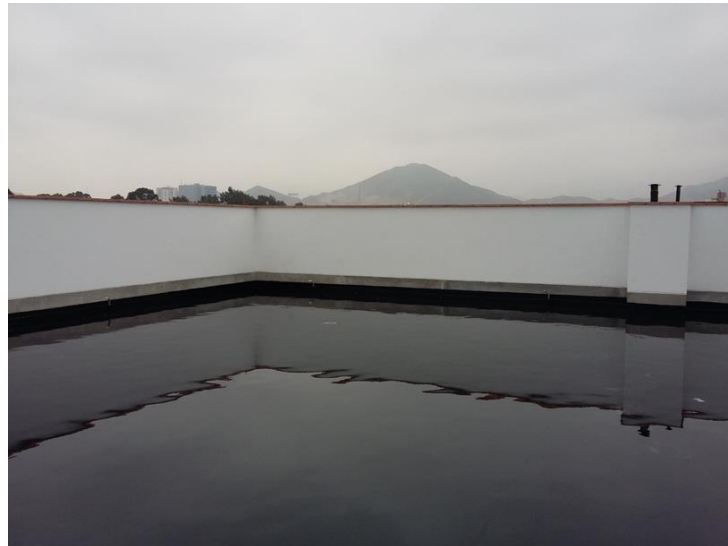
Figura 9. Prueba de estanqueidad
