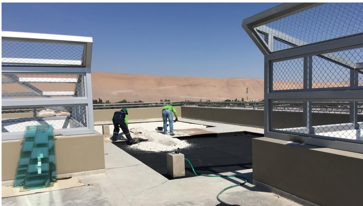
Figura 13. Preparación de sustrato en el lugar de instalación
