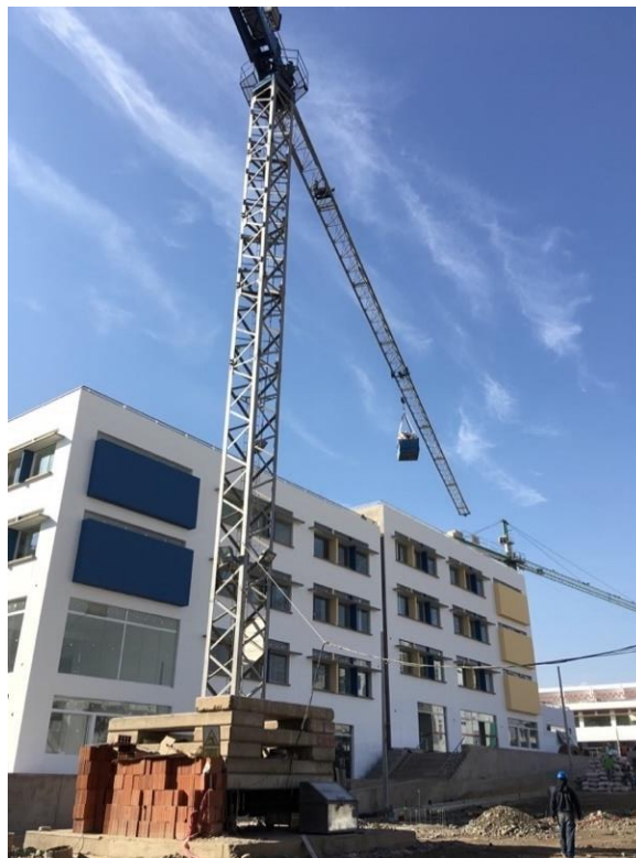
Figura 32. Elevación de sustrato con grúa
