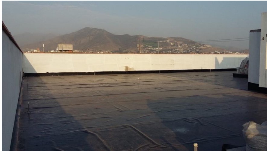
Figura 8. Impermeabilización horizontal y vertical en geomembrana
