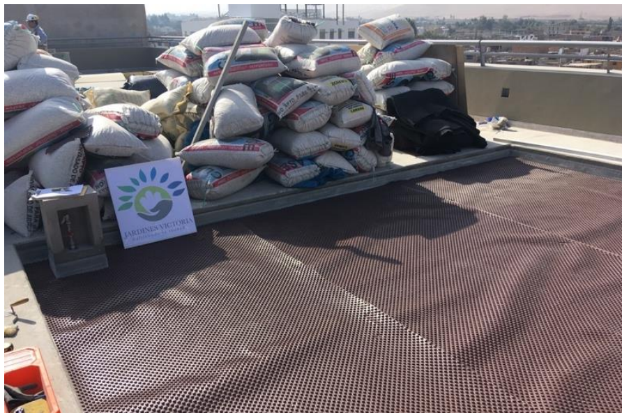
Figura 11. Capa de drenaje sintética
