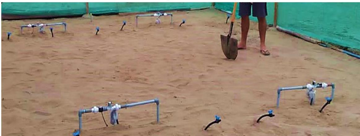
Arcos de riego instalados en terreno
