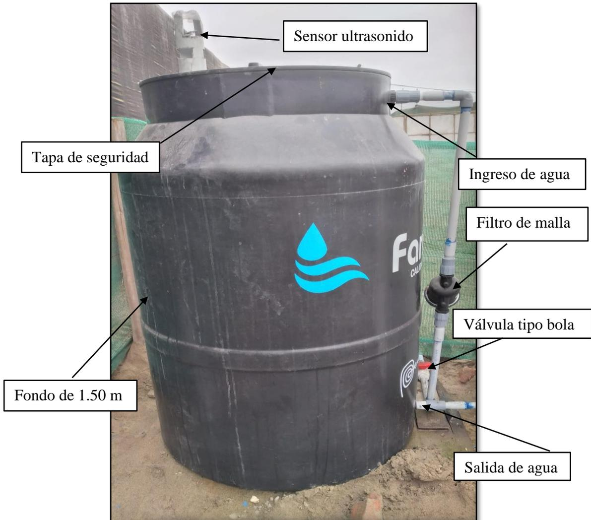
**Figura 17: Accesorios y partes de la fuente de agua**
