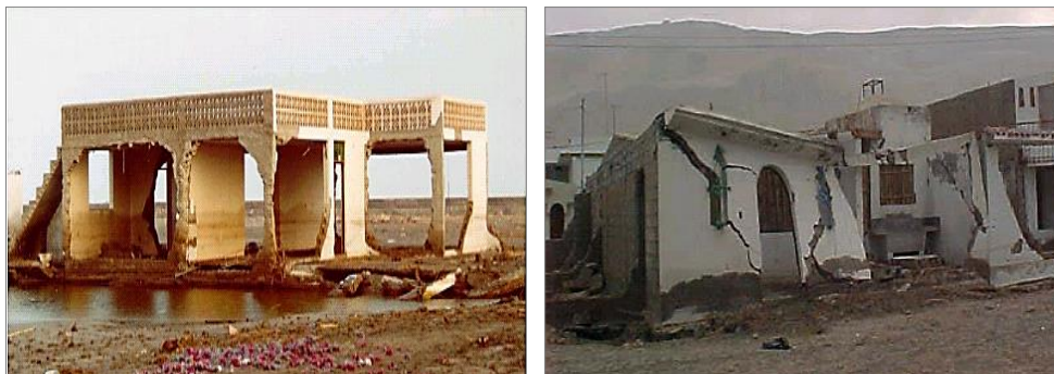
Figura 23. Daños producidos por el momento de flujo en viviendas con bloques de concreto en el balneario de La Punta, producto del tsunami del 23 de junio del 2001, Arequipa
