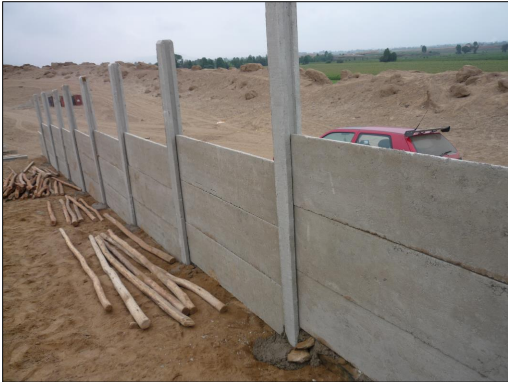
Figura 19: Proceso de instalación de cerco perimétrico
