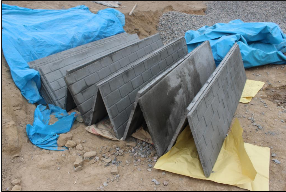
Figura 15: Placas prefabricadas de concreto armado
