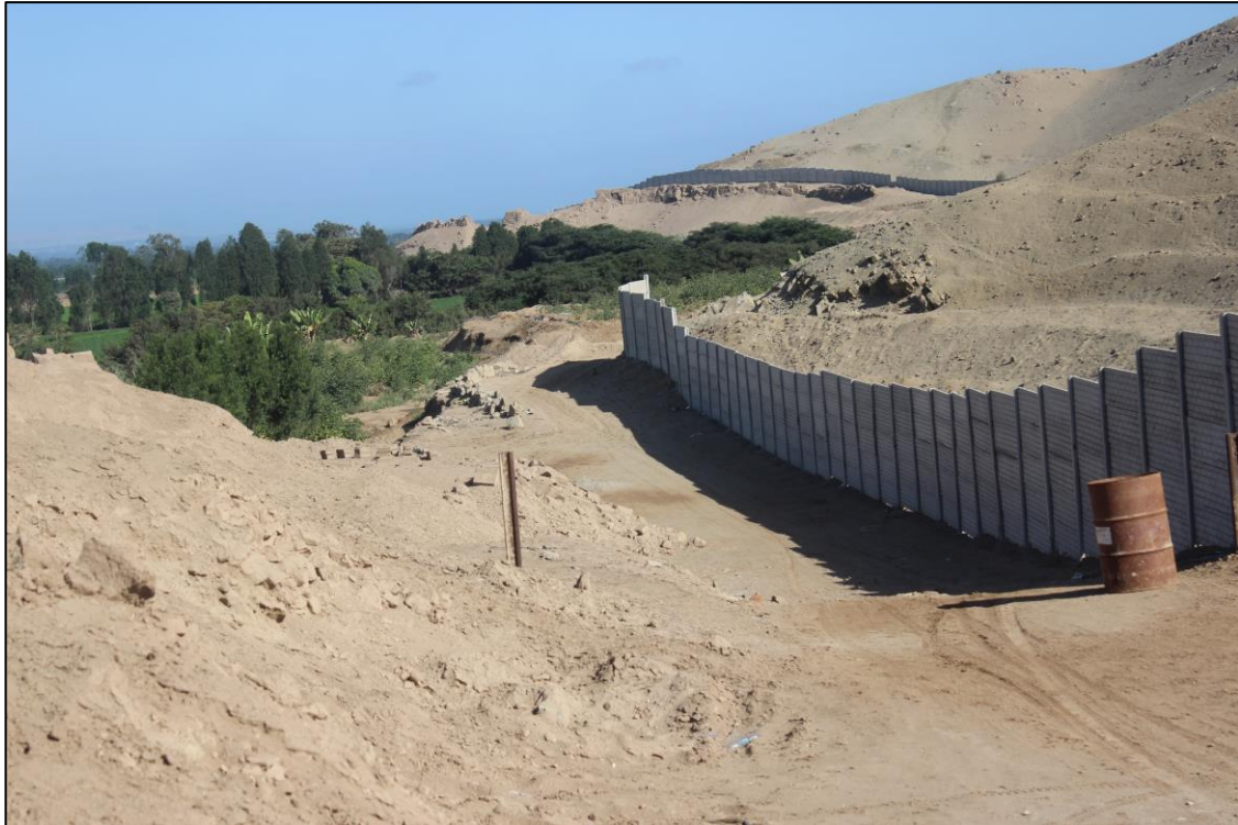
Figura 20: Módulo de prefabricados instalados en campo
