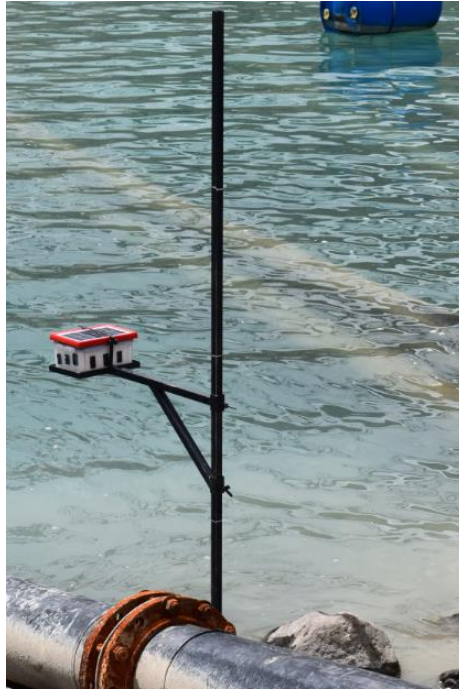
Figura 21: sensor de nivel de laguna montado sobre la estructura metálica
