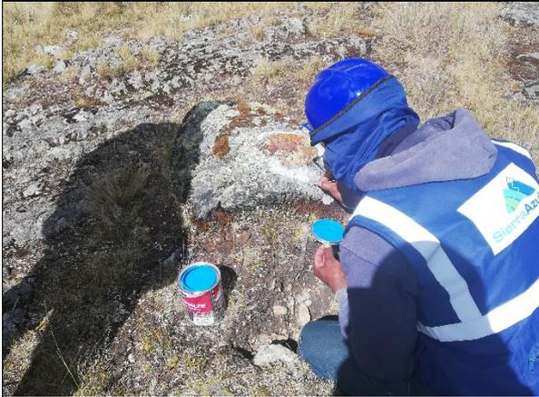
**Fotografía N° 03:** Marcado de las progresivas inicial y final del eje de la corona del dique.
