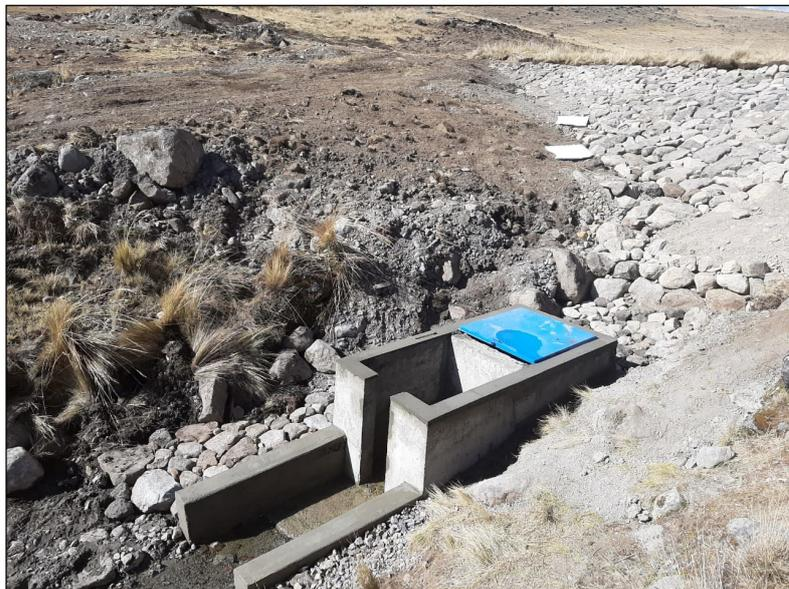
**Figura 54: Vista de la estructura de descarga**
