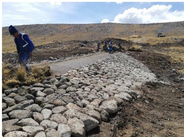
**Figura 43: Enrocado del talud aguas arriba del dique de tierra Challwaqocha 2**
