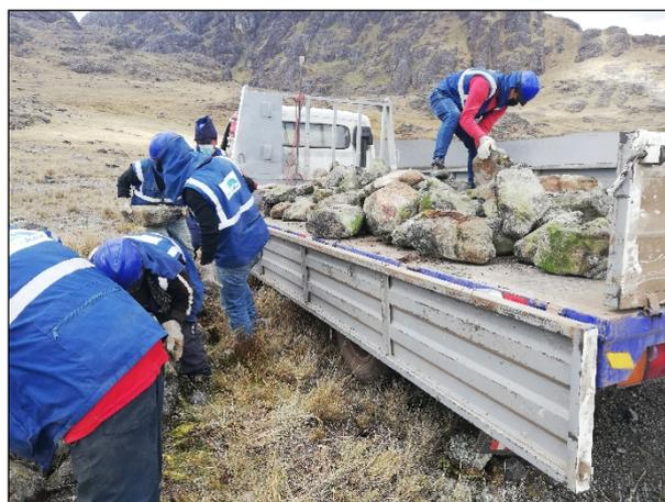
**Figura 41: Traslado de rocas de la cantera hacia el dique de tierra**
