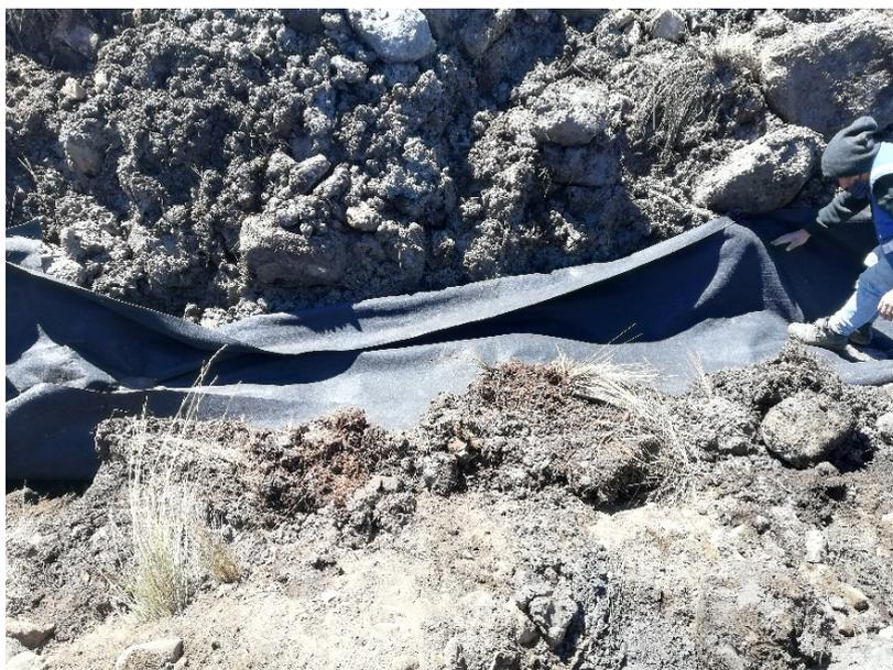
**Figura 28: Instalación del dren en el dique Challwaqocha 2**
