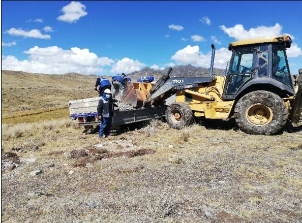
**Fotografía N° 21:** Traslado de agregado al área de dique con ayuda de la retroexcavadora .
