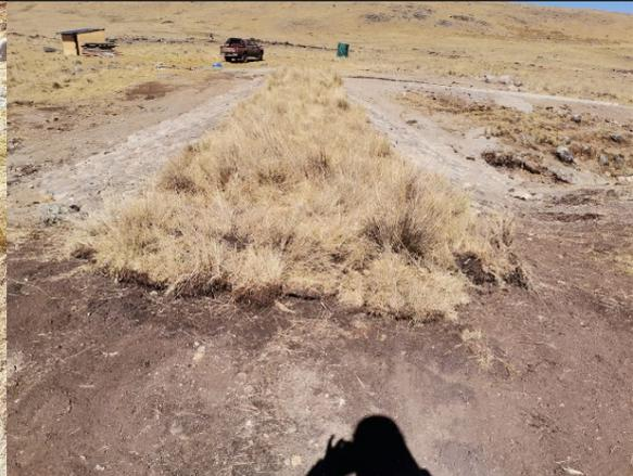
**Fotografía N° 28:** Culminación del dique de tierra Challwaqocha 2. Se aprecia el enchampado en la corona del dique de tierra.
