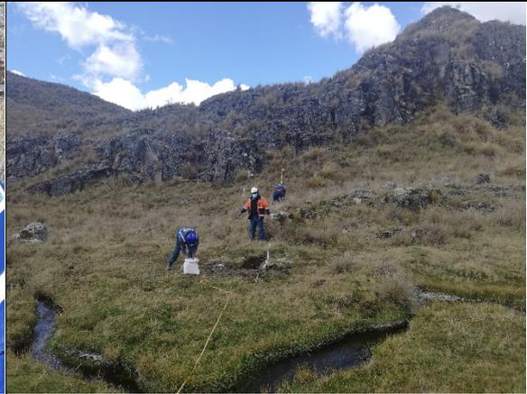
**Fotografía N° 04:** Delimitación del eje de la corona del dique con yeso.
