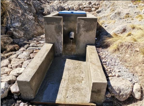
**Fotografía N° 27:** Culminación de la caja de descarga, con enrocado a sus laterales para un mejor confinamiento.
