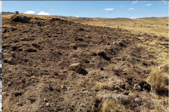
**Fotografía N° 26:** Cierre de canteras en Challwaqocha 2, nivelando para dar uniformidad con el terreno natural.
