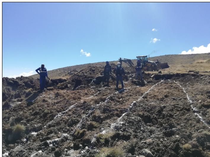
**Figura 25: Remarcado de los trazos del replanteo del dique de tierra Challwaqocha 2**
