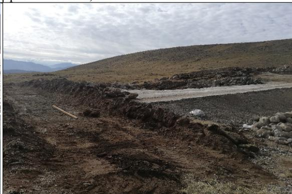
**Fotografía N° 18:** Se realizó la excavación para la construcción del aliviadero; se utilizó la retroexcavadora y trabajos manuales.
