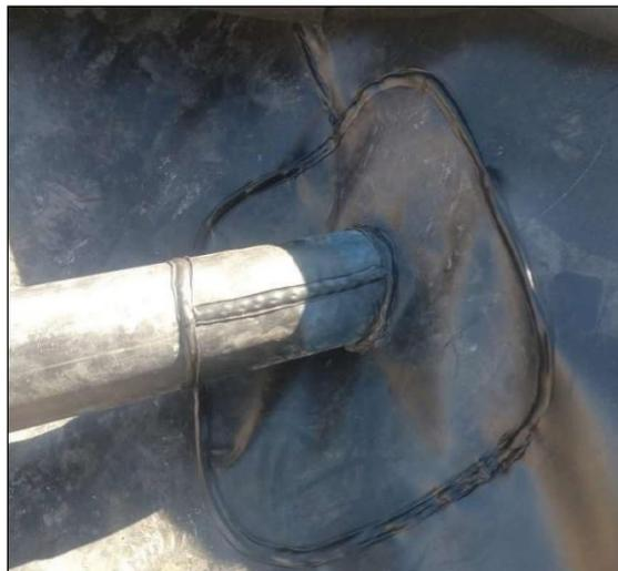
**Figura 39: Empalme de la geomembrana en la tubería del dique de tierra**
