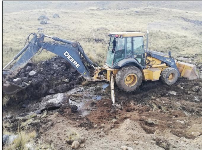
**Figura 26: Movimiento de rocas con la retroexcavadora en el área del dique**
