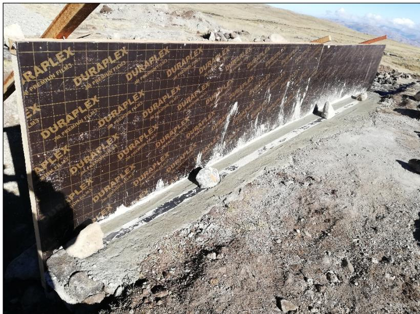
**Figura 37: Polylock instalado para el anclaje de la geomembrana**
