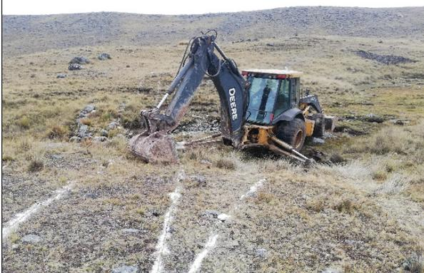
**Fotografía N° 11:** Posicionamiento de la Retroexcavadora para iniciar la limpieza del área del dique. Para ello, se desocupó las zonas aledañas para evitar accidentes.
