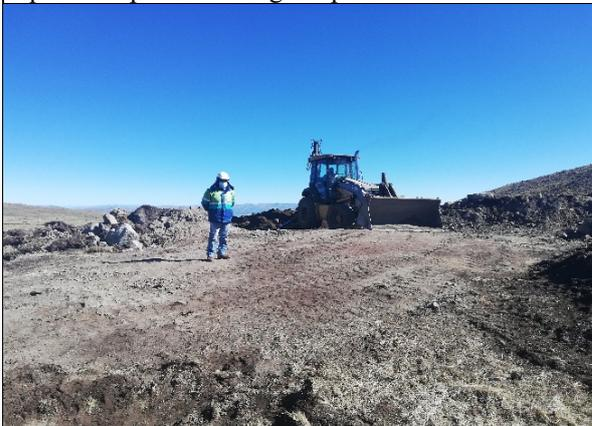
**Fotografía N° 15:** Se dio comienzo a la reconformación de las canteras, refinando los desniveles con la finalidad de que se asemeje al terreno natural.
