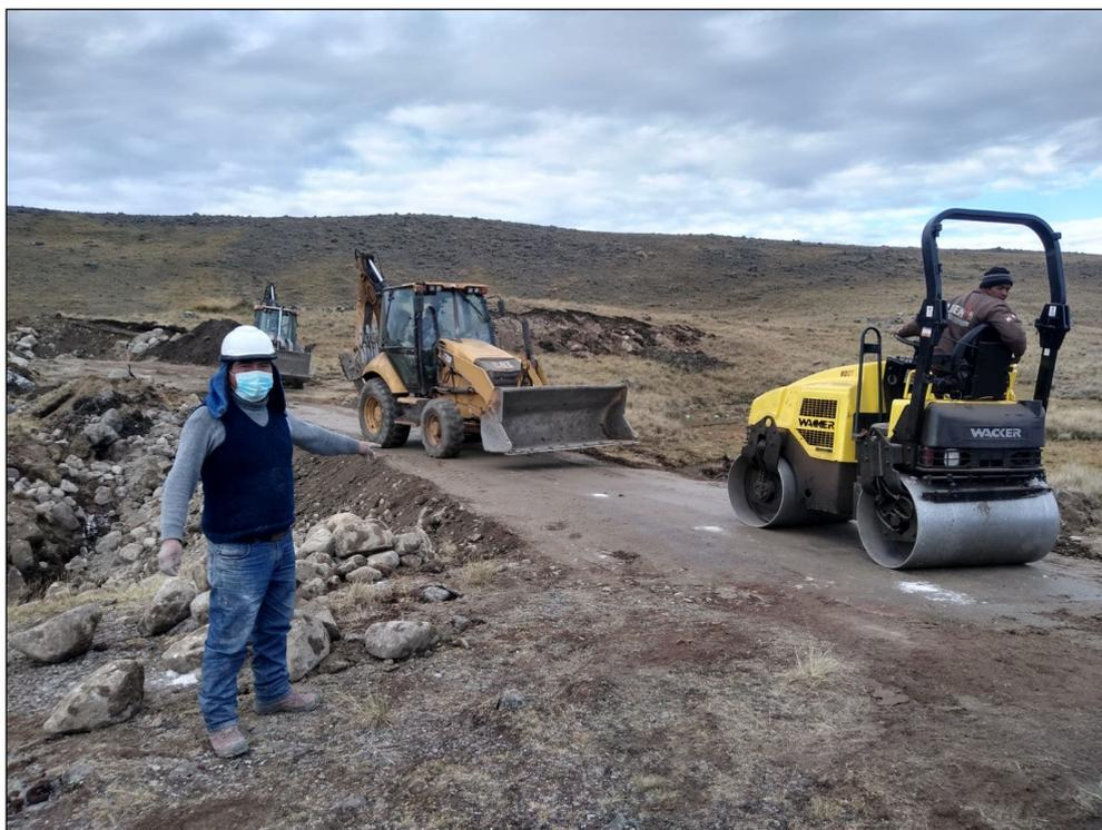
**Figura 29: Conformación del cuerpo del dique de tierra Challwaqocha 2**
