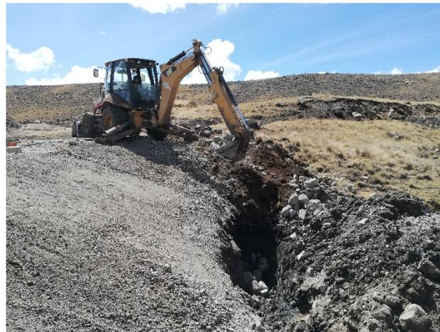
**Figura 35: Excavación del dentellón en la cara húmeda del cuerpo del dique de tierra Challwaqocha 2**
