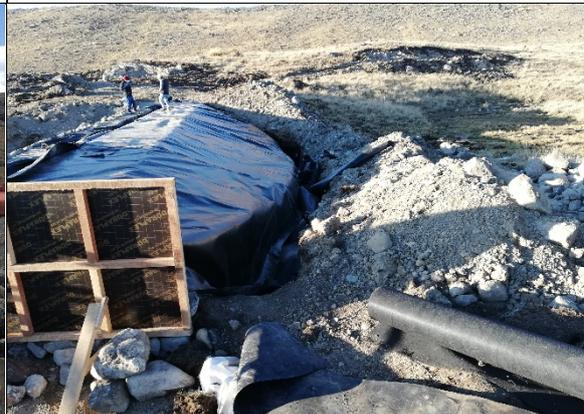
**Fotografía N° 24:** Instalación de la Geomembrana en Challwaqocha 2.
