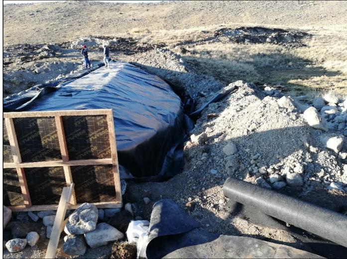
**Figura 38: Impermeabilización del cuerpo del dique de tierra Challwaqocha 2**
