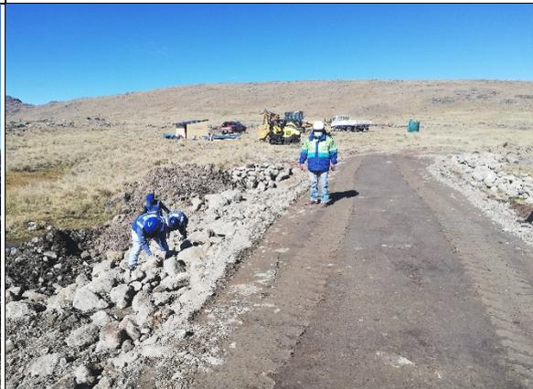
**Fotografía N° 16:** Se dio comienzo al enrocado de la pantalla seca. Se precisa la utilización de los guantes de cuero, las cuales, debido a su desgaste por la abrasión, fueron renovadas.
