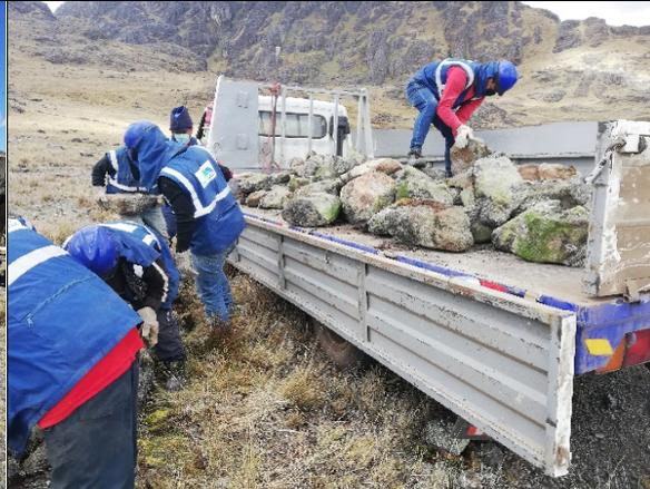
**Fotografía N° 22:** Recolección de rocas para los trabajos de enrocado del cuerpo del dique y aliviadero.
