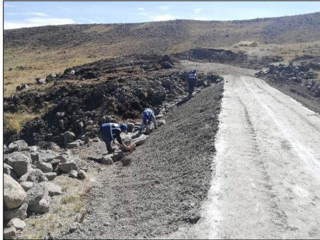
**Figura 42: Empedrado de las paredes del talud aguas abajo del dique Challwaqocha 2**
