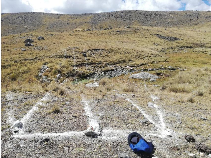
**Figura 20: Vista del trazo y replanteo del dique de Challwaqocha 2**
