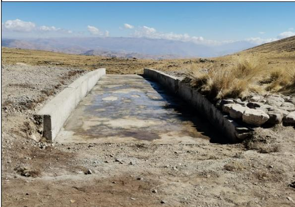
**Fotografía N° 29:** Foto del aliviadero en Challwaqocha 2 luego del curado.
