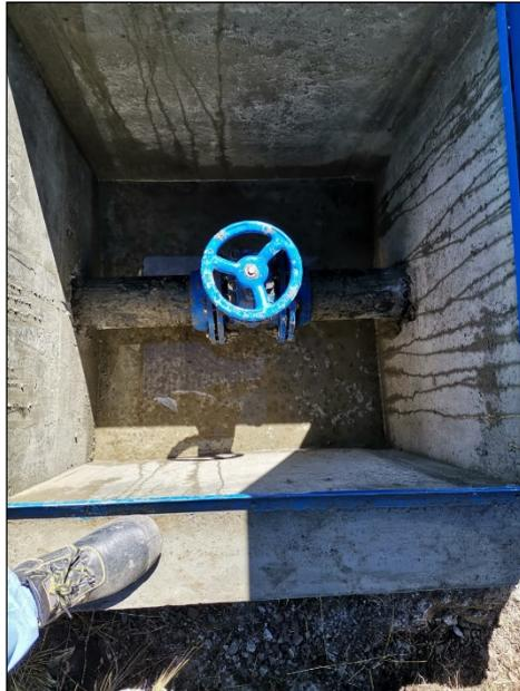
**Figura 53: Vista de la válvula instalada en la estructura de descarga**
