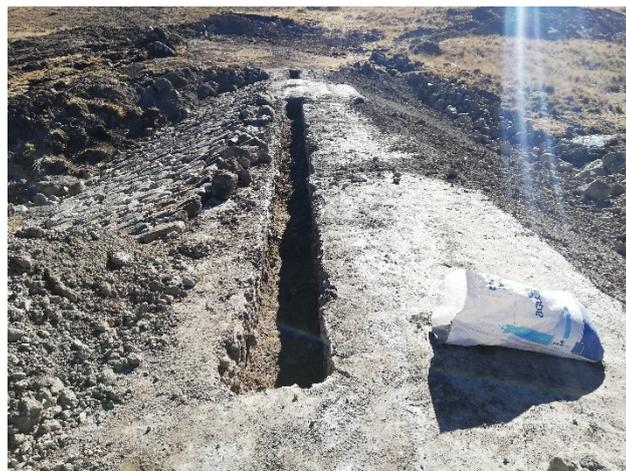
**Figura 36: Excavación de la zanja de anclaje en la corona del dique de tierra Challwaqocha 2**
