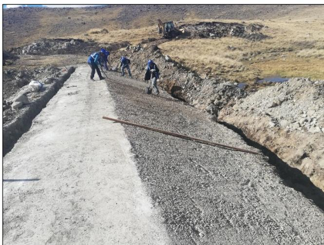
**Figura 30: Corte y perfilado del talud del dique Challwaqocha 2**
