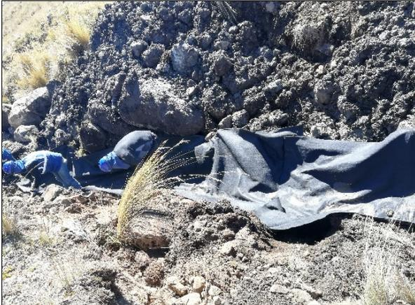
**Fotografía N° 13:** Instalación del dren para Challwaqocha 2. Las zonas aledañas fueron previamente fijadas por la retroexcavadora asegurar que no se produzca ningún tipo de deslizamientos.
