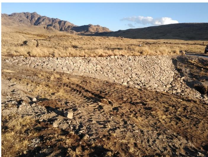
**Figura 44: Recubrimiento de la corona del dique con champa**
