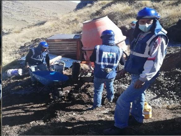
**Fotografía N° 20:** Preparación de la mezcla para el vaciado del aliviadero en Challwaqocha 2.
