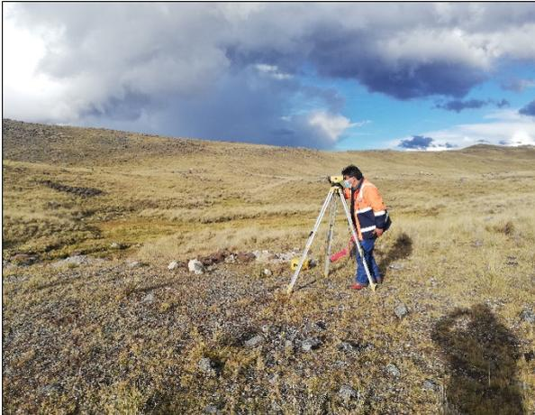
**Fotografía N° 01:** Operación del Nivel de ingeniero, para las actividades de trazo y replanteo.
