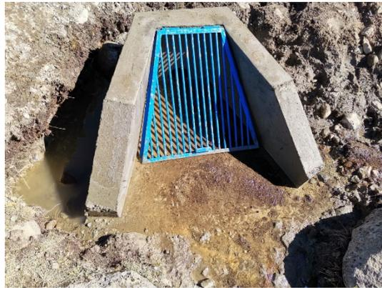
**Figura 57: Estructura de toma de agua finalizado**
