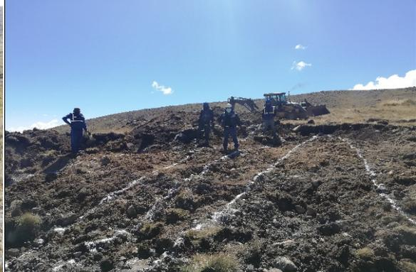
**Fotografía N° 12:** Luego de la limpieza del área del dique, se volvió a remarcar con yeso las líneas principales del dique de tierra.
