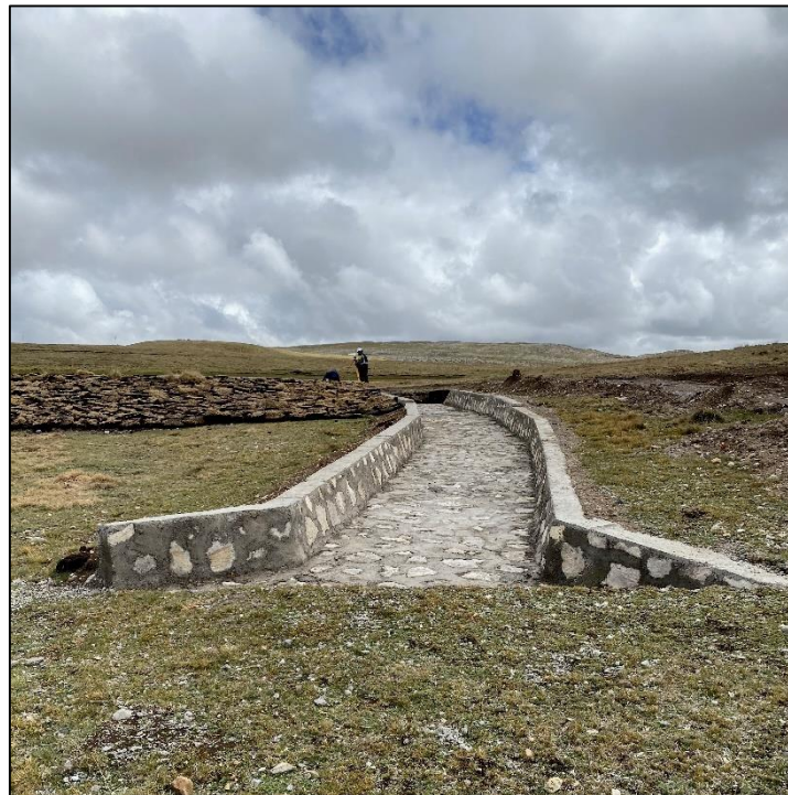
Figura 57: Fotografía de la salida del aliviadero de la gocha Ocshagoto (Pas1-2019-Q5)
