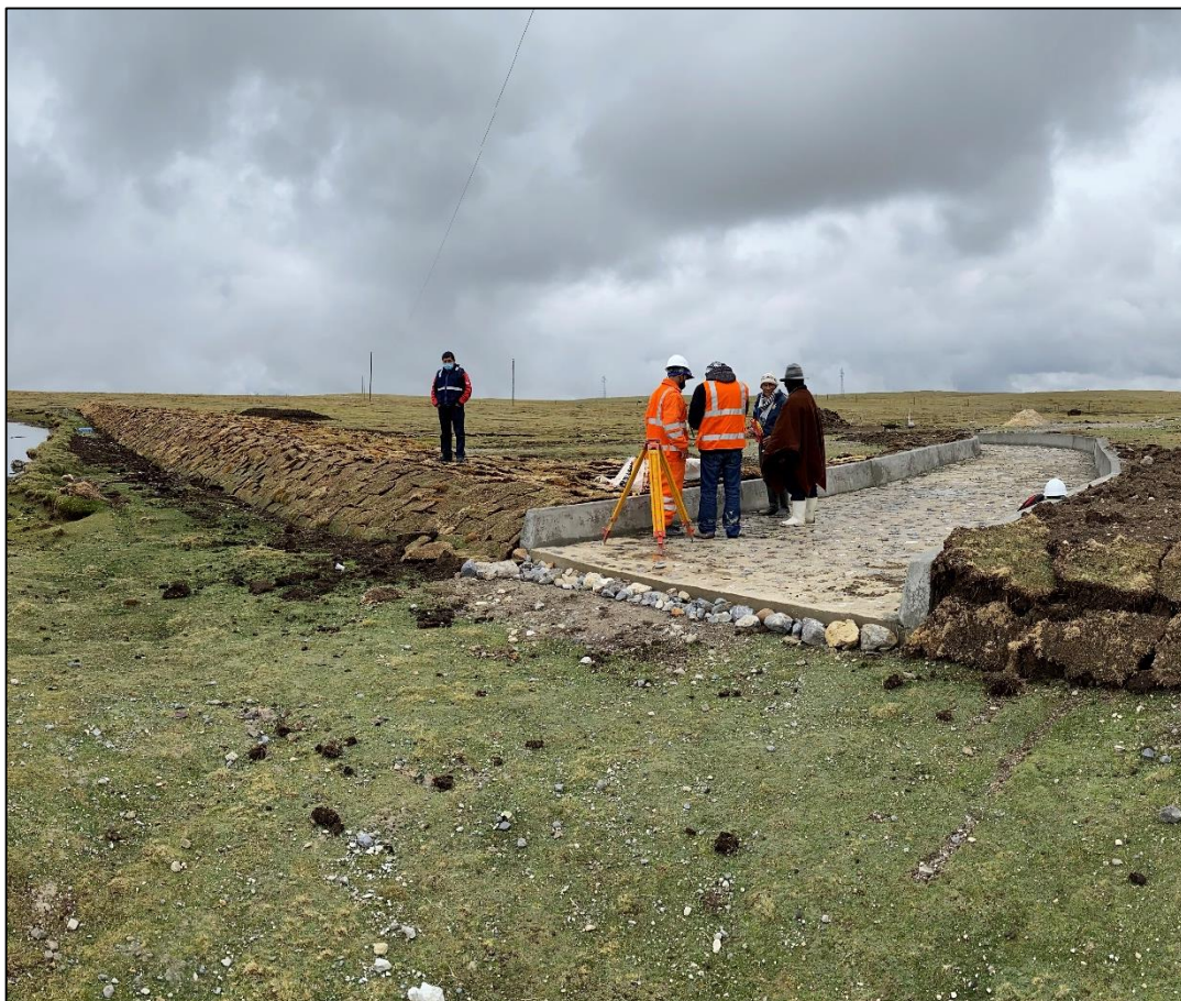
Figura 34: Fotografía del dique construido en la gocha Llamacocha (Pas1-2019-Q3)
