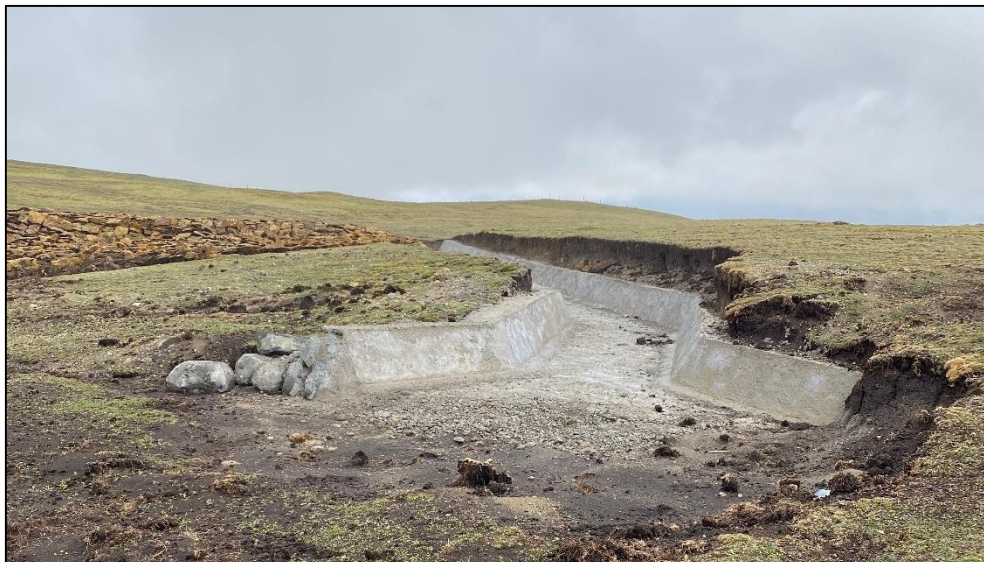
Figura 24: Fotografía de la salida del aliviadero de la qocha Los Andes (Pas1-2019-Q1)
