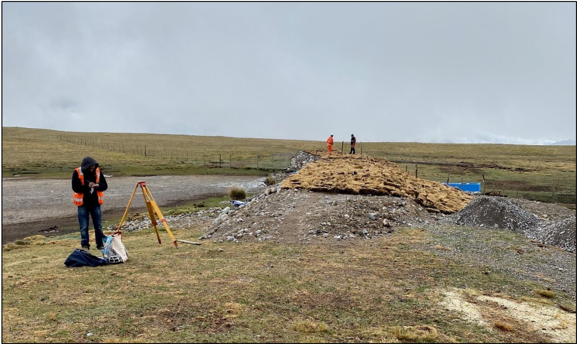
Figura 25: Fotografía del dique construido y obras conexas en la qocha Estanco Chico (Pas1-2019-Q2)
