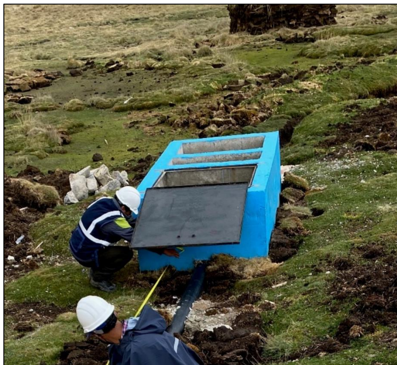
Figura 44: Fotografía de la estructura de la descarga (caja de válvulas) de la qocha Uchuy Huascacocha (Pas1-2019-Q4)
