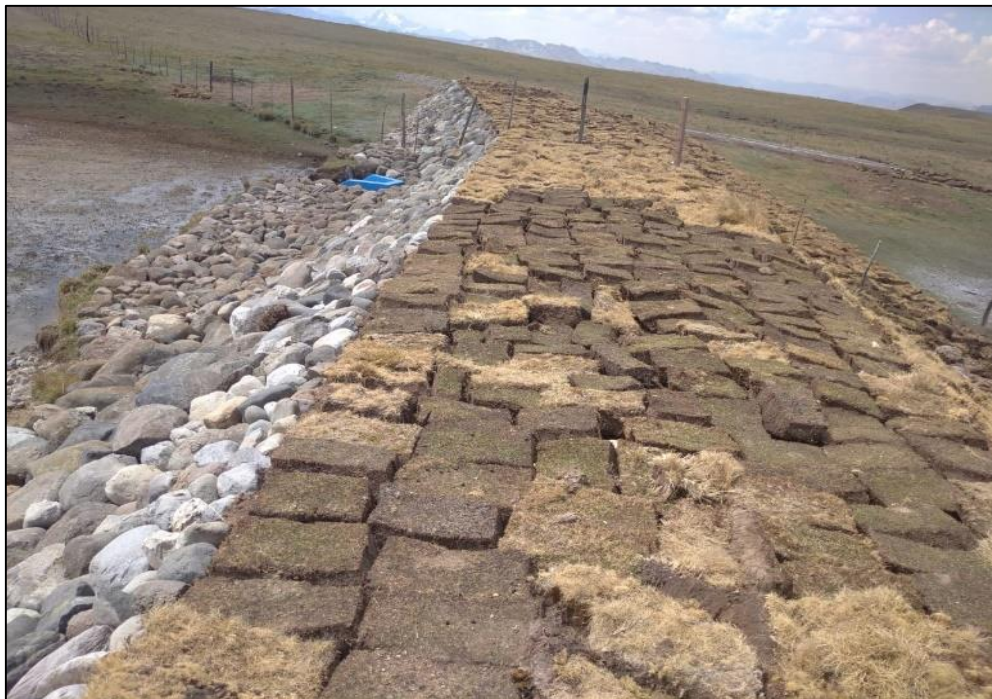
Figura 26: Fotografía del dique construido en la qocha Estanco Chico (Pas1-2019-Q2)
