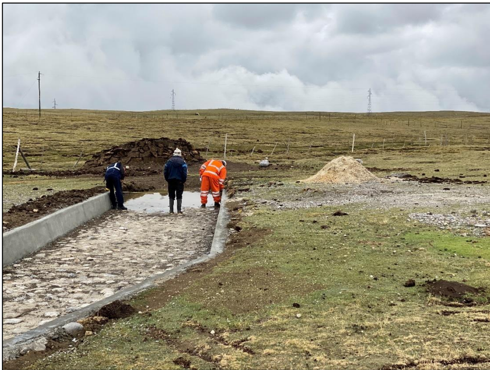
Figura 40: Fotografía de la salida del aliviadero de la qocha Llamacocha (Pas1-2019-Q3)
