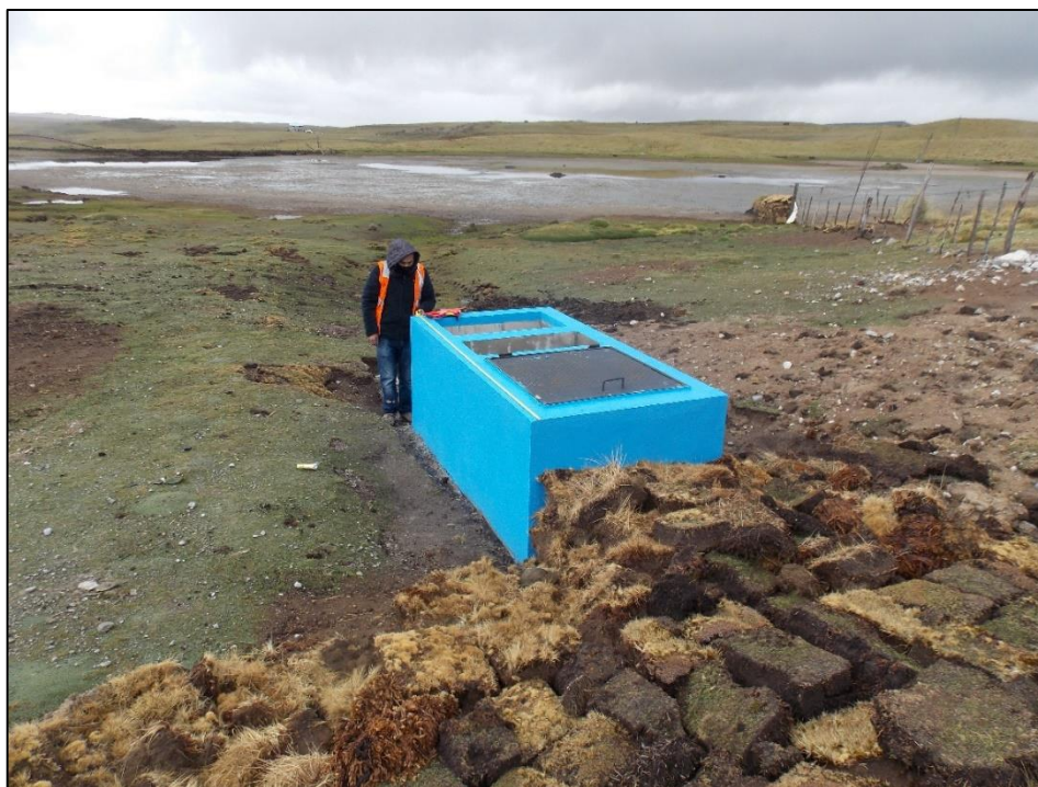
Figura 28: Fotografía de la estructura de la descarga (caja de válvulas) de la qocha Estanco Chico (Pas1-2019-Q2)
