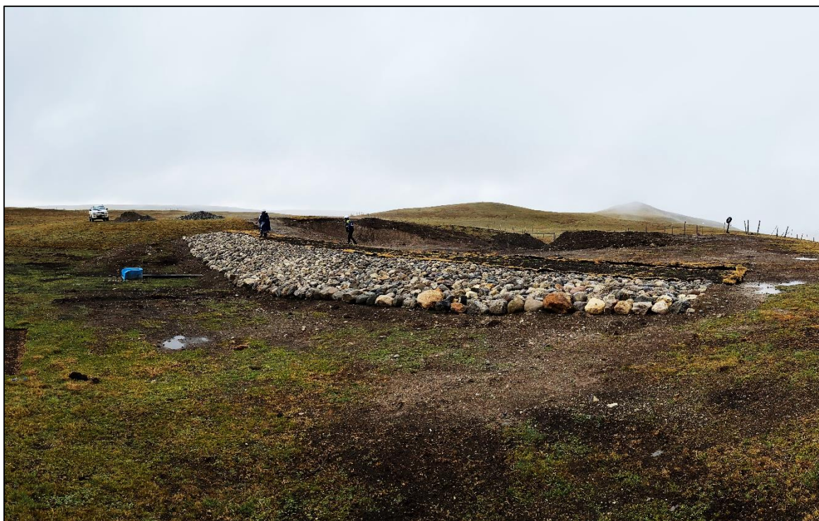
Figura 59: Fotografía del dique construido en la qocha Sagra Rumi (Pas1-2019-Q6)
