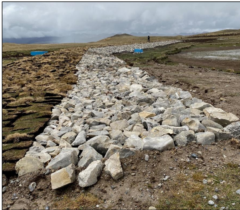
Figura 41: Fotografía del dique construido y obras conexas en la qocha Uchuy Huascacocha (Pas1-2019-Q4)
