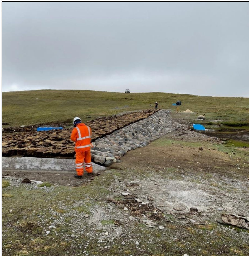
Figura 17: Fotografía del dique construido y obras conexas en la qocha Los Andes (Pas1-2019-Q1)
