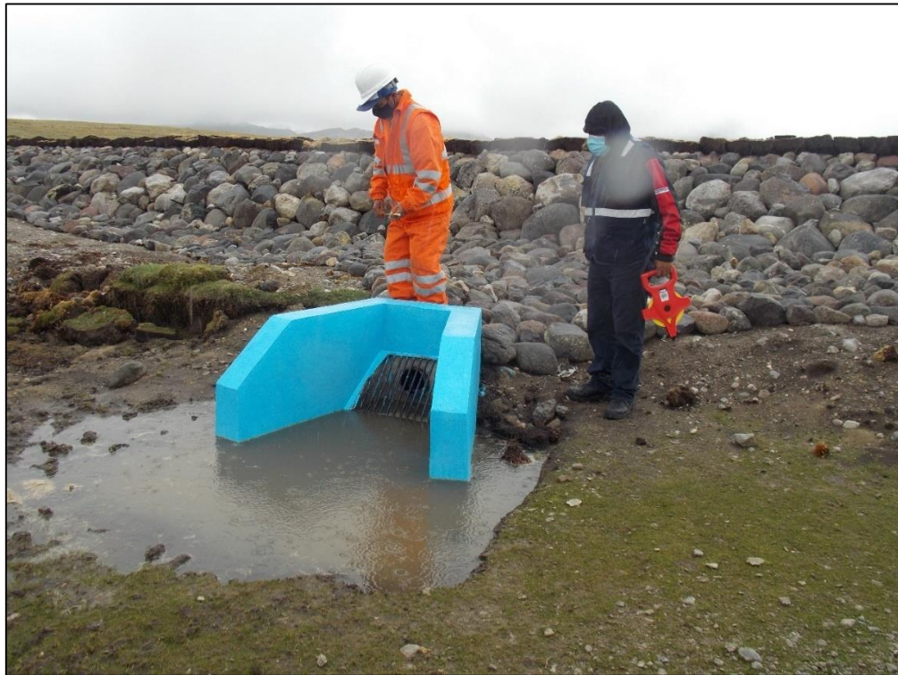
Figura 19: Fotografía de la estructura de la toma (captación) de la qocha Los Andes (Pas1-2019-Q1)
