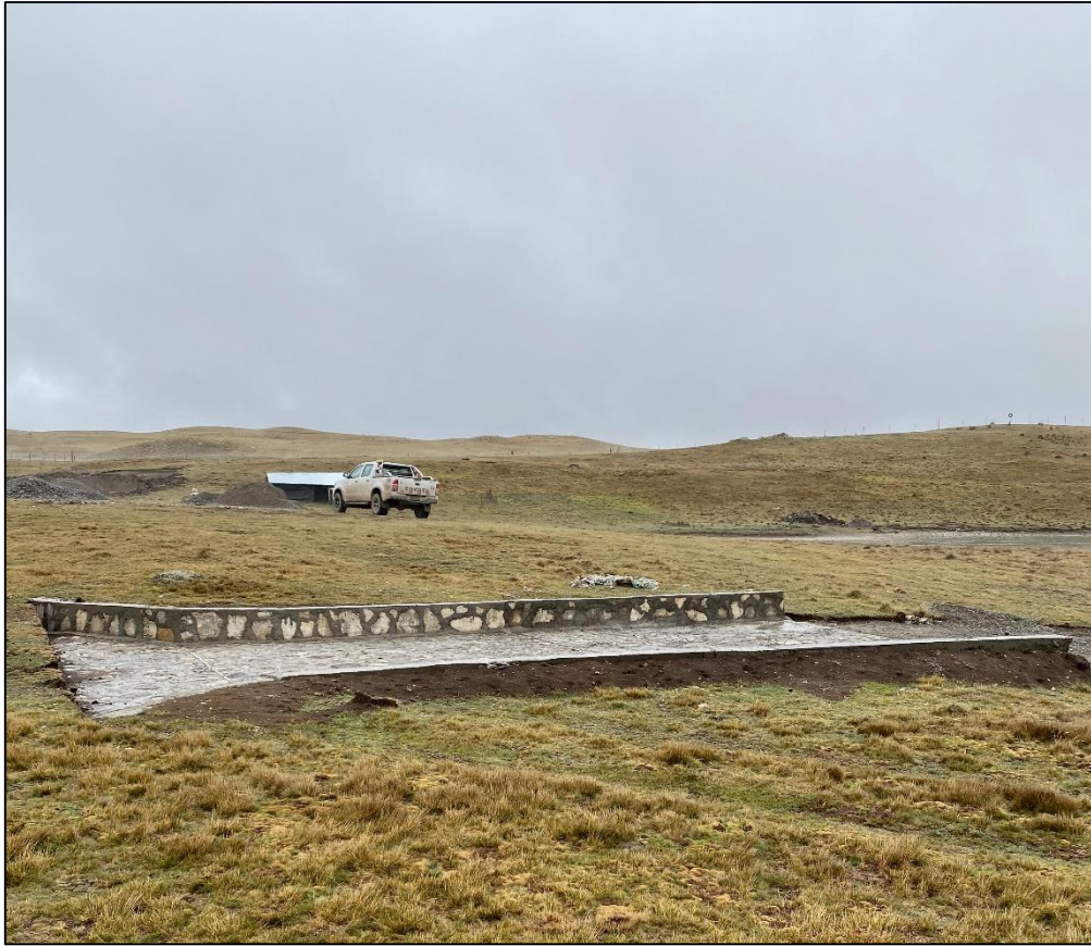
Figura 64: Fotografía del aliviadero de la qocha Sagra Rumi (Pas1-2019-Q6)
