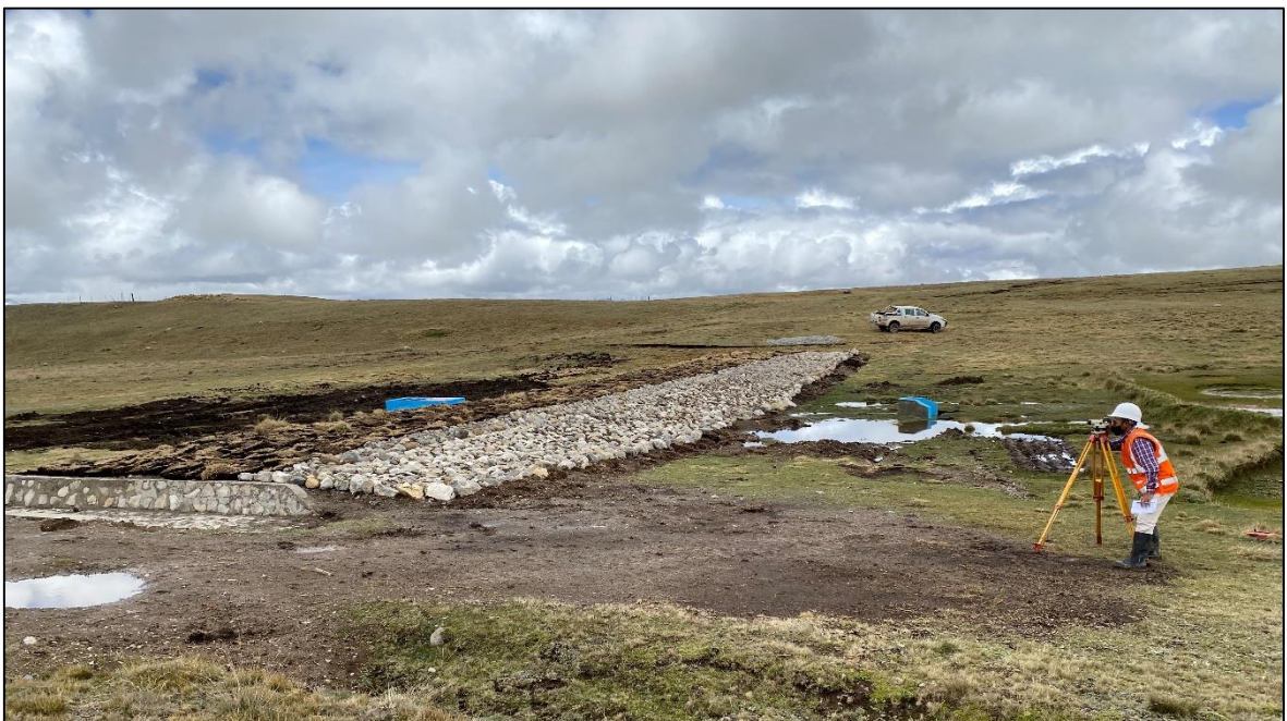
Figura 51: Fotografía del dique construido en la qocha Ocshagoto (Pas1-2019-Q5)
