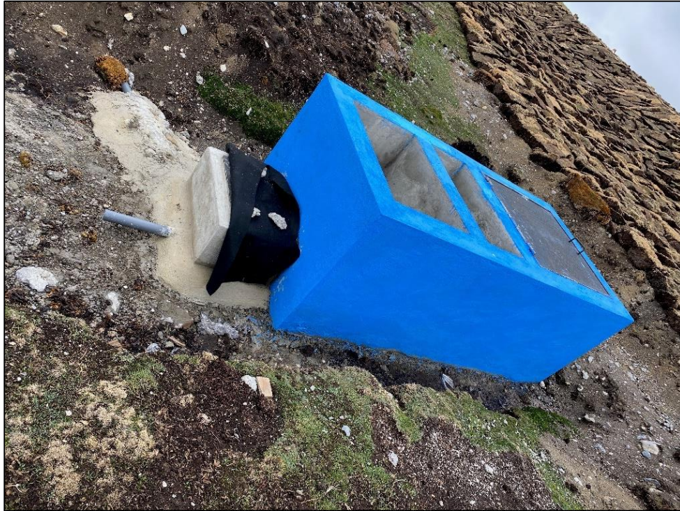
Figura 20: Fotografía de la estructura de la descarga (caja de válvulas) de la qocha Los Andes (Pas1-2019-Q1)
