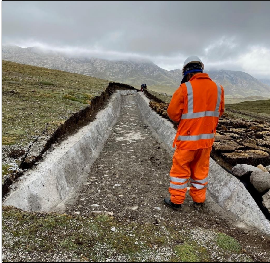
Figura 23: Fotografía de la entrada del aliviadero de la qocha Los Andes (Pas1-2019-Q1)
