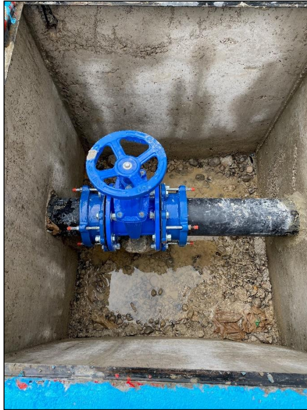
Figura 54: Fotografía de la válvula instalada en la gocha Ocshagoto (Pas1-2019-Q5)
