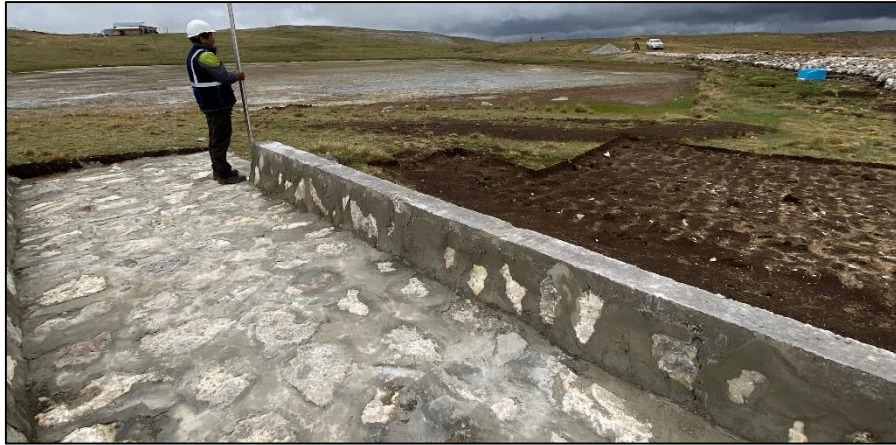
Figura 47: Fotografía de la entrada del aliviadero de la qocha Uchuy Huascacocha (Pas1-2019-Q4)
