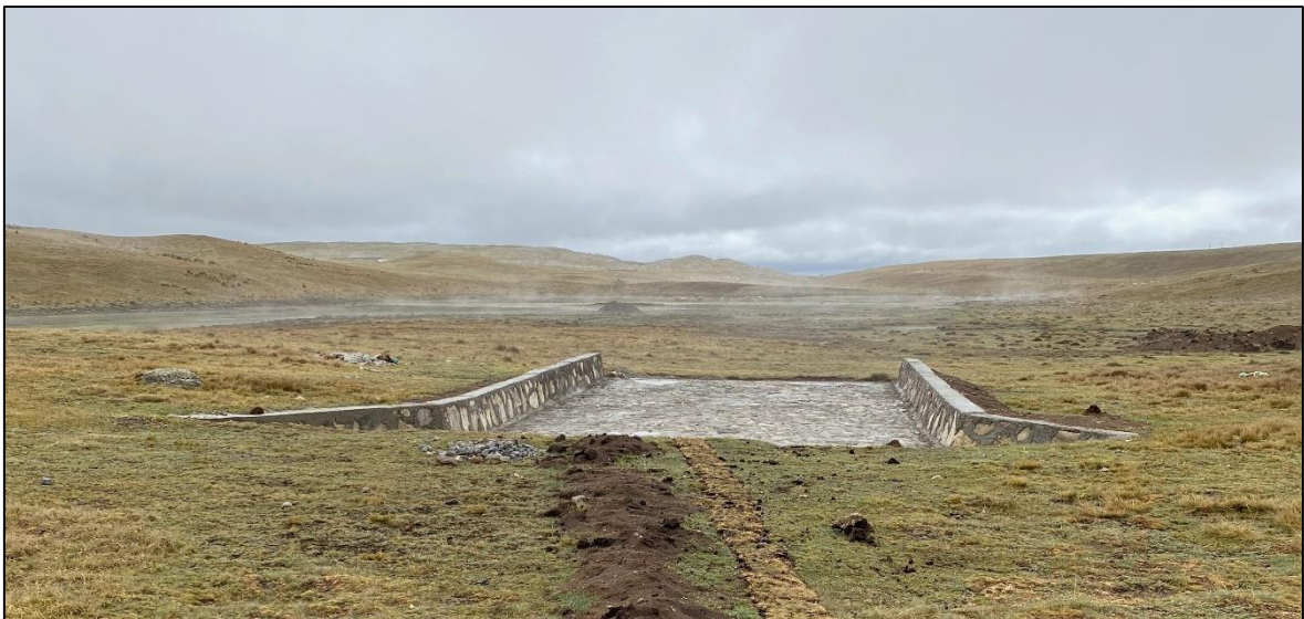
Figura 65: Fotografía captada de la salida del aliviadero de la qocha Sagra Rumi (Pas1-2019-Q6)
