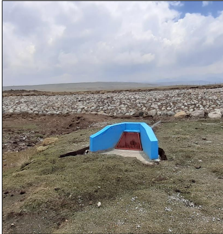
Figura 60: Fotografía de la estructura de la toma (captación) de la qocha Sagra Rumi (Pas1-2019-Q6)
