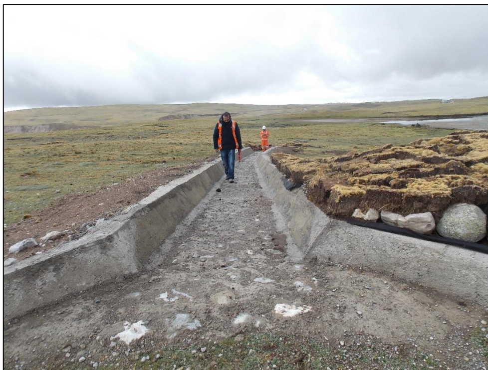
Figura 31: Fotografía de la entrada del aliviadero de la gocha Estanco Chico (Pas1-2019-Q2)
