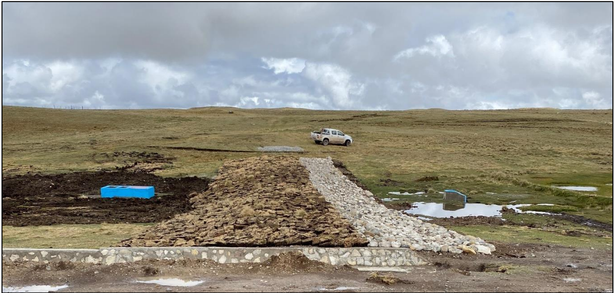
Figura 50: Fotografía del dique construido y obras conexas en la qocha Ocshagoto (Pas1-2019-Q5)
