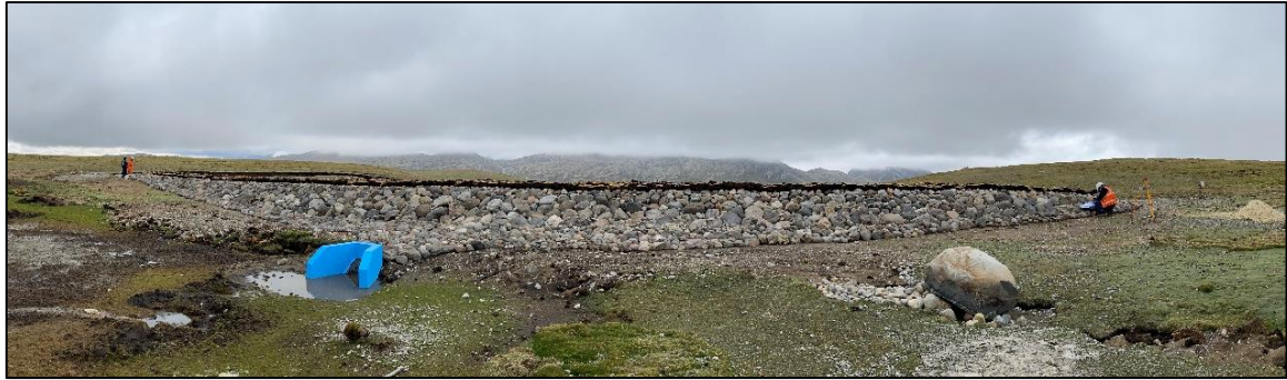
Figura 18: Fotografía del dique construido en la qocha Los Andes (Pas1-2019-Q1)
