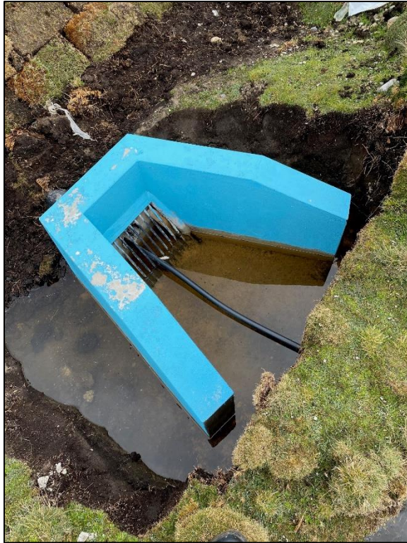
Figura 35: Fotografía de la estructura de la toma (captación) de la qocha Llamacocha (Pas1-2019-Q3)
