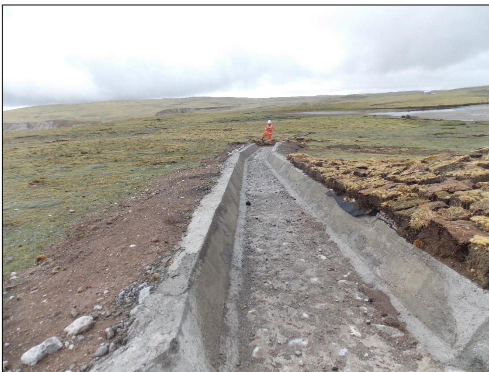
Figura 32: Fotografía del aliviadero de la gocha Estanco Chico (Pas1-2019-Q2)
