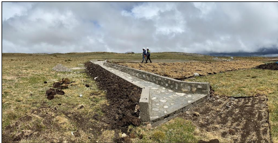
Figura 48: Fotografía de la salida del aliviadero de la qocha Uchuy Huascacocha (Pas1-2019-Q4)
