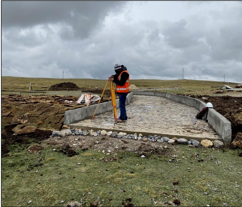
Figura 39: Fotografía de la entrada del aliviadero de la qocha Llamacocha (Pas1-2019-Q3)
