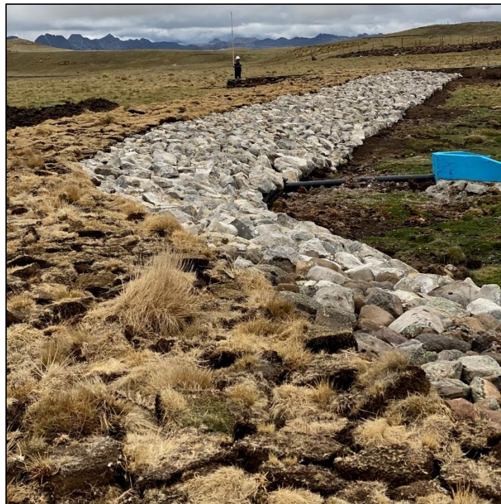
Figura 42: Fotografía del dique construido en la qocha Uchuy Huascacocha (Pas1-2019-Q4)
