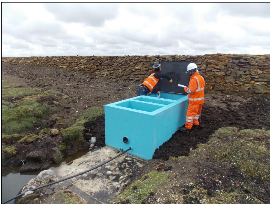
Figura 36: Fotografía de la estructura de la descarga (caja de válvulas) de la qocha Llamacocha (Pas1-2019-Q3)
