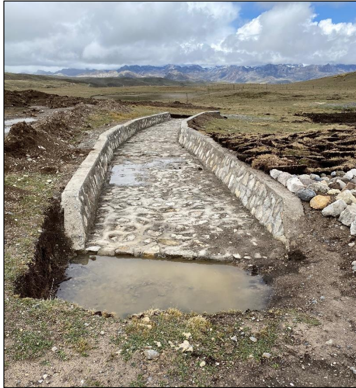
Figura 56: Fotografía de la entrada del aliviadero de la gocha Ocshagoto (Pas1-2019-Q5)
