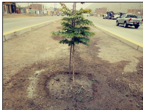
Verificación Plateo y tutorado “Berma central Av. Tupac Amaru”
