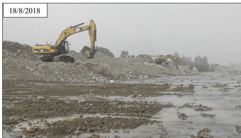
Foto 3 Trabajos de descolmatación y encauzamiento en la progresiva km 1+100
