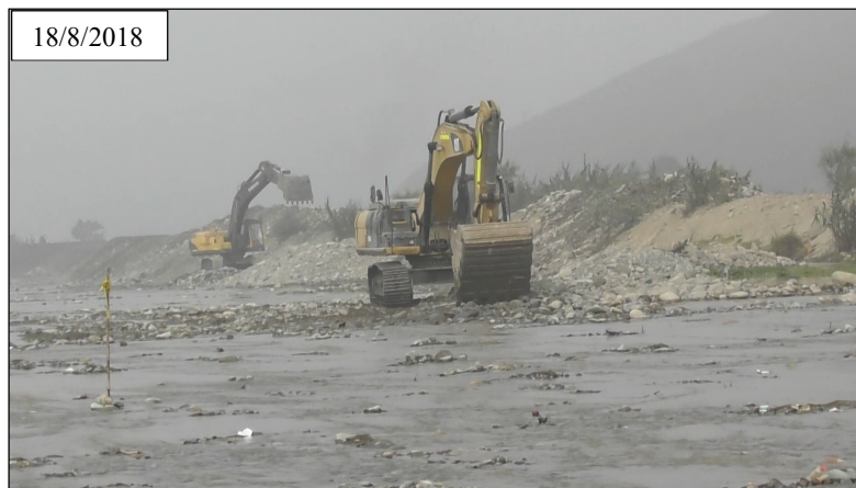
Foto 2 Trabajos de descolmatación y encauzamiento en la progresiva km 0+780
