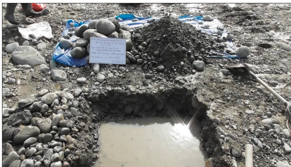
Foto 10 calicata 10 (C-10) para extraer muestras del material depositado por el río en su cauce.
