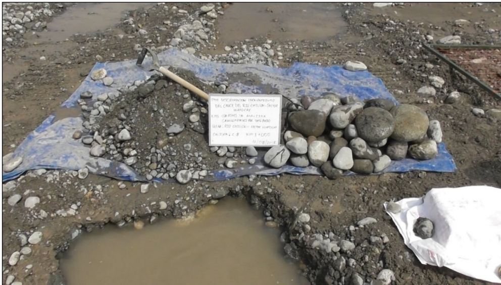
Foto 8 calicata 8 (C-8) para extraer muestras del material depositado por el río en su cauce.
