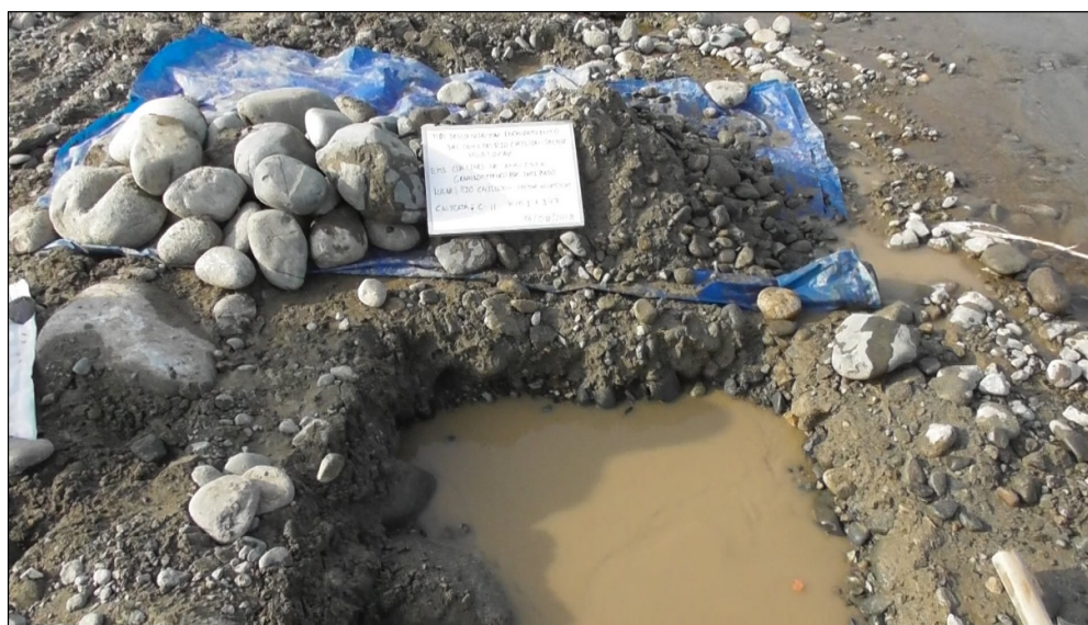
Foto 11 calicata 11 (C-11) para extraer muestras del material depositado por el río en su cauce.
