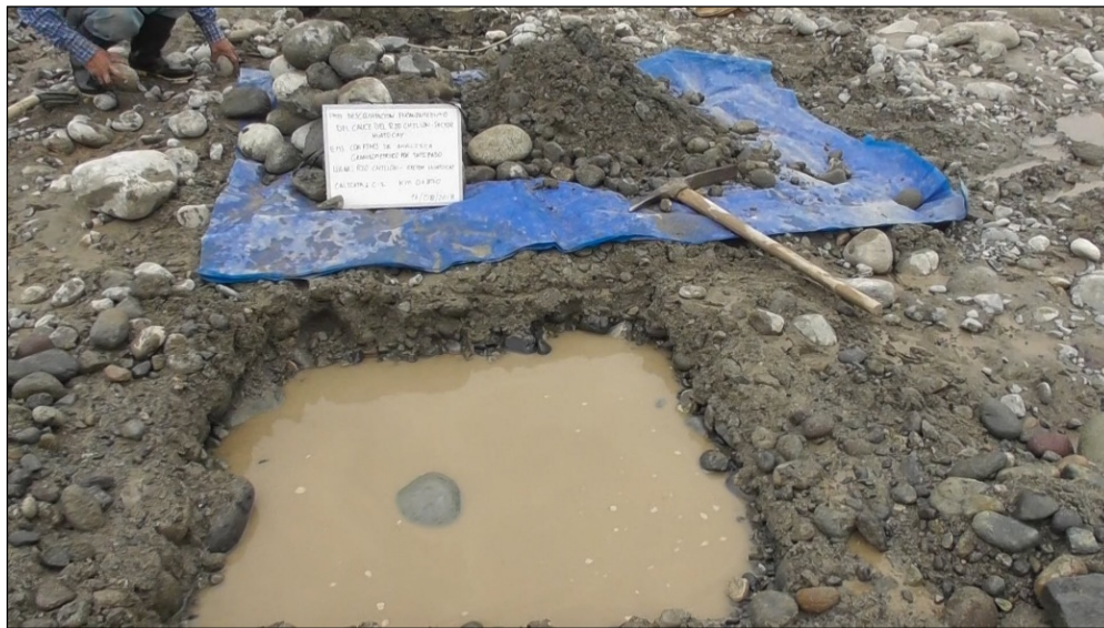
Foto 7 calicata 7 (C-7) para extraer muestras del material depositado por el río en su cauce.
