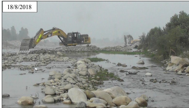
Foto 1 Trabajos de descolmatación y encauzamiento en la progresiva km 0+420
