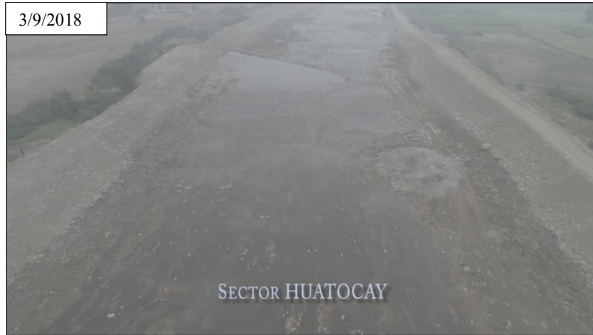
Foto 7 vista aérea del cauce antes del tránsito de la avenida en la progresiva km 0+200
