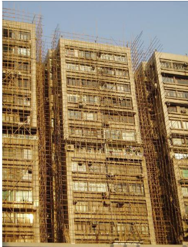
Figura 11: Andamiaje de bambú en la ciudad de Kowloon, Hong Kong.
