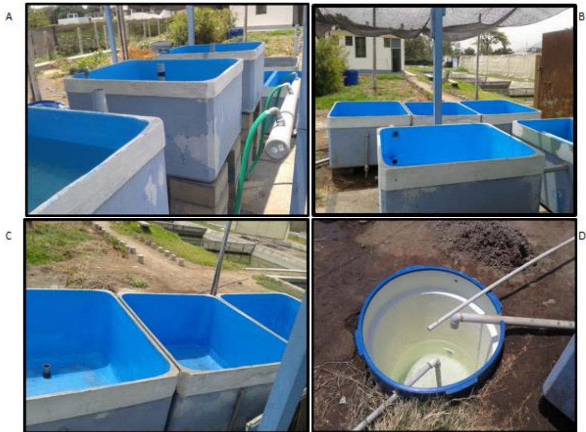
Figura 4: Diseño y acondicionamiento del sistema acuapónico: (A) tanques de peces con sistema de desfogue mediante mangueras hacia tubería colectora de efluentes, (B) tanques de filtración y biofiltro, (C) tanques para el cultivo hidropónico y (D) tanque de almacenamiento
