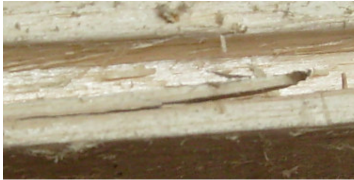
FOTO 7: DEFECTO DE GRANO LEVANTADO FUERTE EN EL ENSAYO DE MOLDURADO
