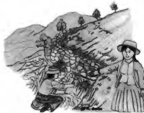
Figura 3.31. Uso de residuos forestales para la construcción de terrazas de formación lenta
