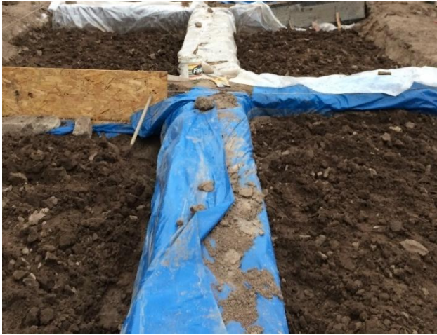
i. Creación de muros de contención
