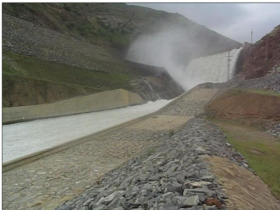
**Figura 32:** Operación del aliviadero de demasías para una descarga de  $125.0 \text{ m}^3/\text{s}$  (fecha: 31/03/2008).
