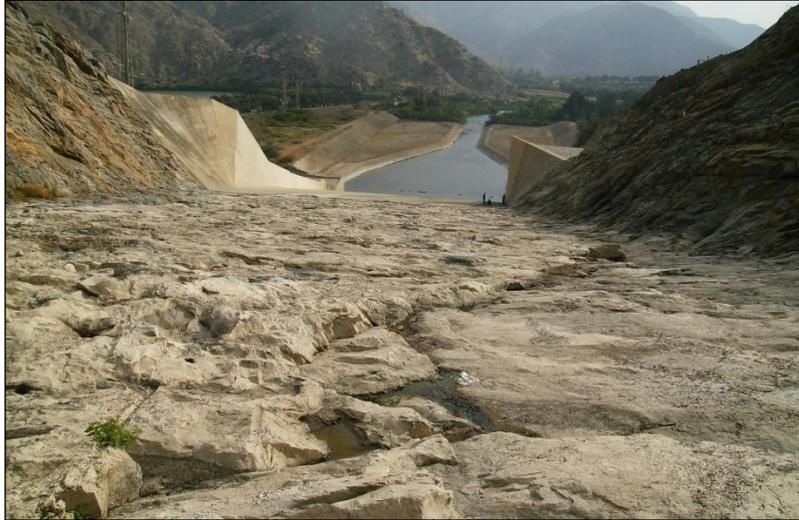
**Foto 4:** Rápida natural en roca, rápida de concreto y canal de descarga.
