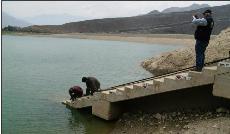
**Foto 1:** Punto de control para la medición del nivel de agua en el embalse.
