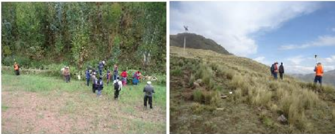
Imagen N° 5: Replanteo de la faja de servidumbre y medición de linderos con GPS
