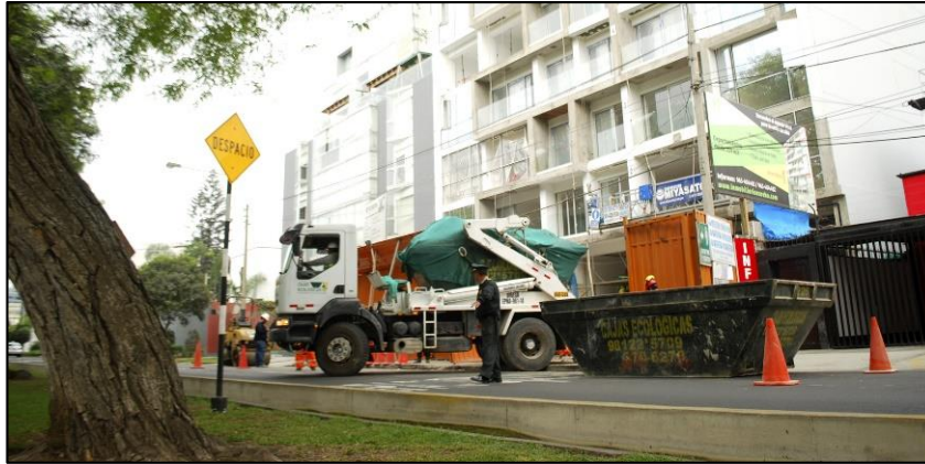
Figura 3: Vista de servicio de recolección mediante contenedores metálicos.
