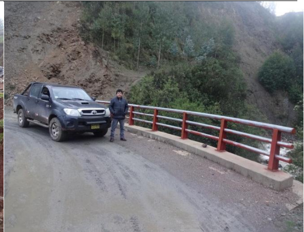
FOTO 8. Puente carrozable - interconexión a la comunidad de Sachaj.
