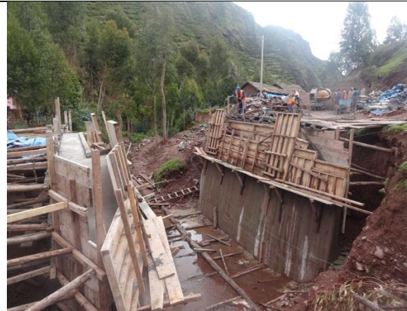
FOTO 7. Construcción de puente carrozable - interconexión a la comunidad de Usi
