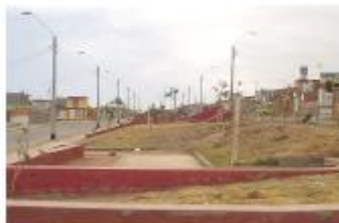
Falta de mantenimiento y riego de las bermas centrales.
