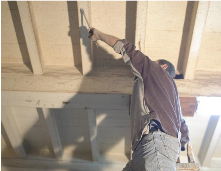
Figura 11: Inspección superficial a lo largo de la superficie de la madera
