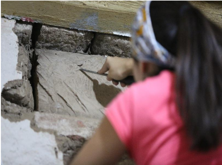
Figura 12: Inspección superficial de los cabezales
