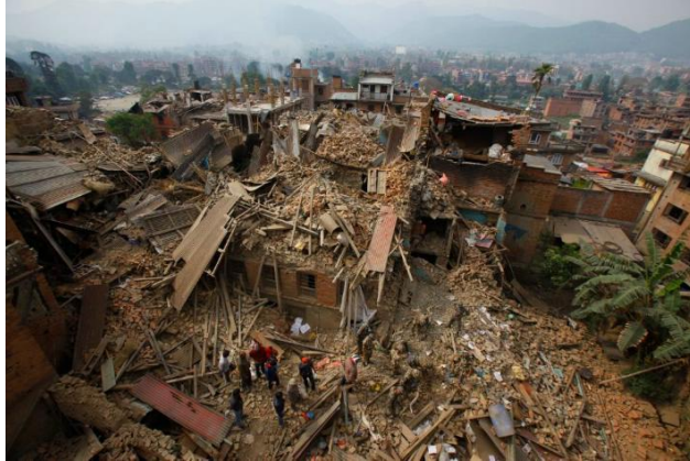
Figura. 3 Catastrófico terremoto. Fuente: Gutierrez y Manco, 2006.
