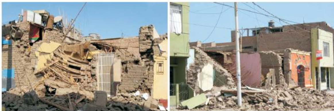
Figura. 16 y Figura 17. Desplome de muro en Ica 2007. Fuente: Tavera, 2008.
