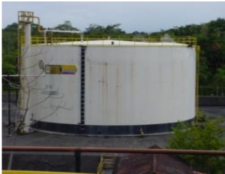
FOTO N° 6: Tanques desnatador
