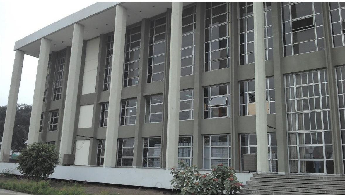
Vista posterior izquierda del edificio de la Biblioteca Agrícola Nacional.
