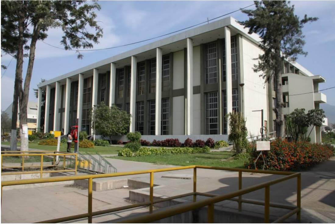
Vista lateral derecha del edificio de la Biblioteca Agrícola Nacional.
