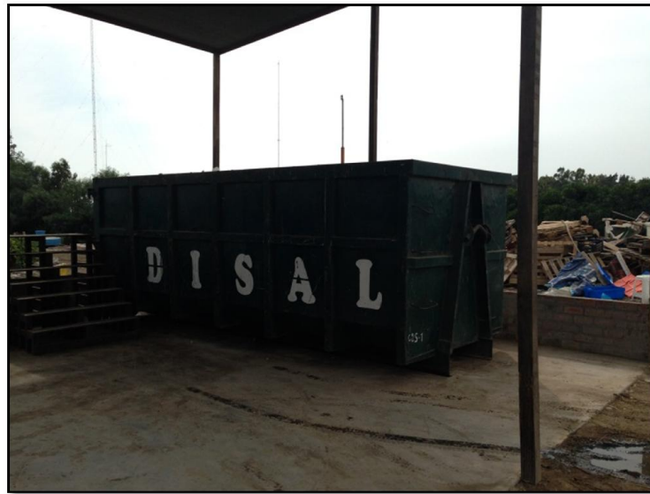
Figura 15: Contenedor de almacenamiento de residuos sólidos no re aprovechables.
